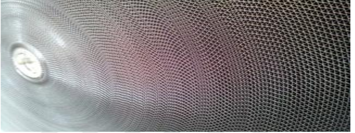
Şekil 2.6. Dolgulu duyulur ısı tekerlekleri (Anonim 2015)
