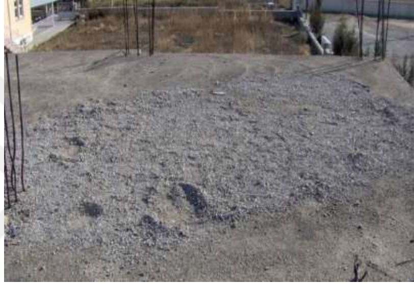
Őekil 2.11. Donma-zlme evrimi sonrası hasar gren Denizli ili - Iřıklı ilesi betonarme dřeme (Baradan ve ark. 2002)
