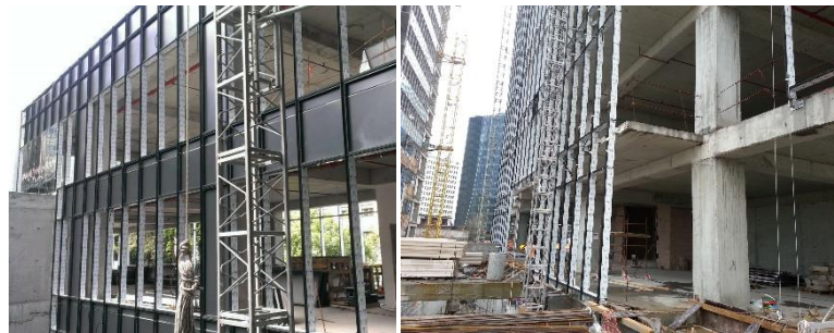
Şekil 2.1. Çubuk sistem taşıyıcı profil montaj uygulaması (Kişisel arşiv 2016).
