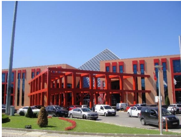
Şekil 3.1. BTSO hafif asma giydirme cepheye sahip binası (Kişisel arşiv 2019).
