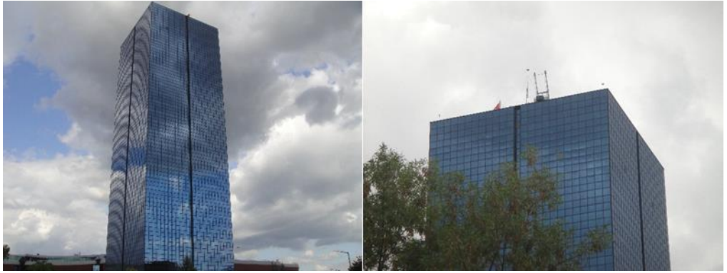
Şekil 2.4. Buttim ofis binası ve cephe temizleme ray sistemi (Kişisel arşiv 2019).
