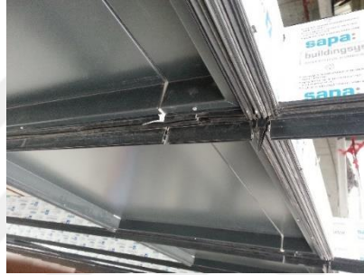
Şekil 2.2. Sızdırmazlık fitil uygulaması (Kişisel arşiv 2016).
