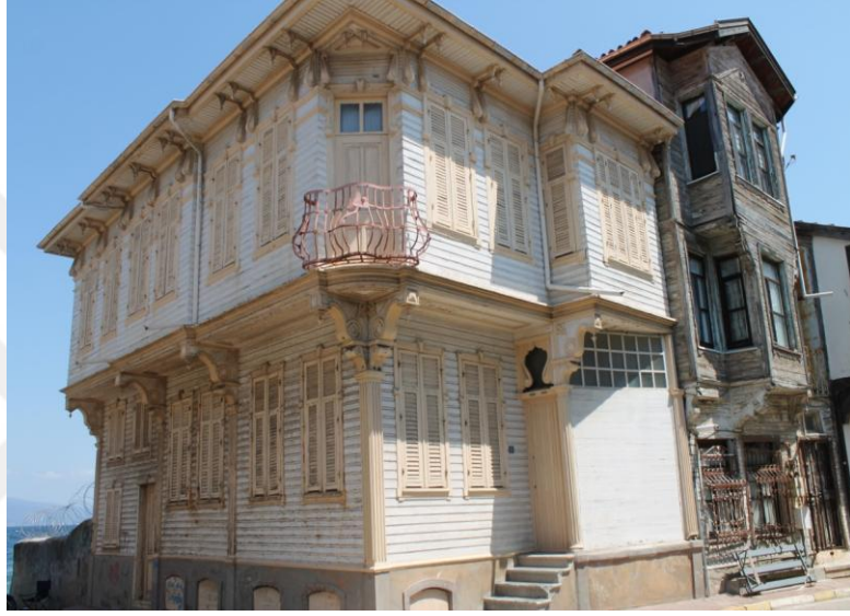
Şekil 4.12. Geleneksel yapılardaki malzeme kullanımı örneği
