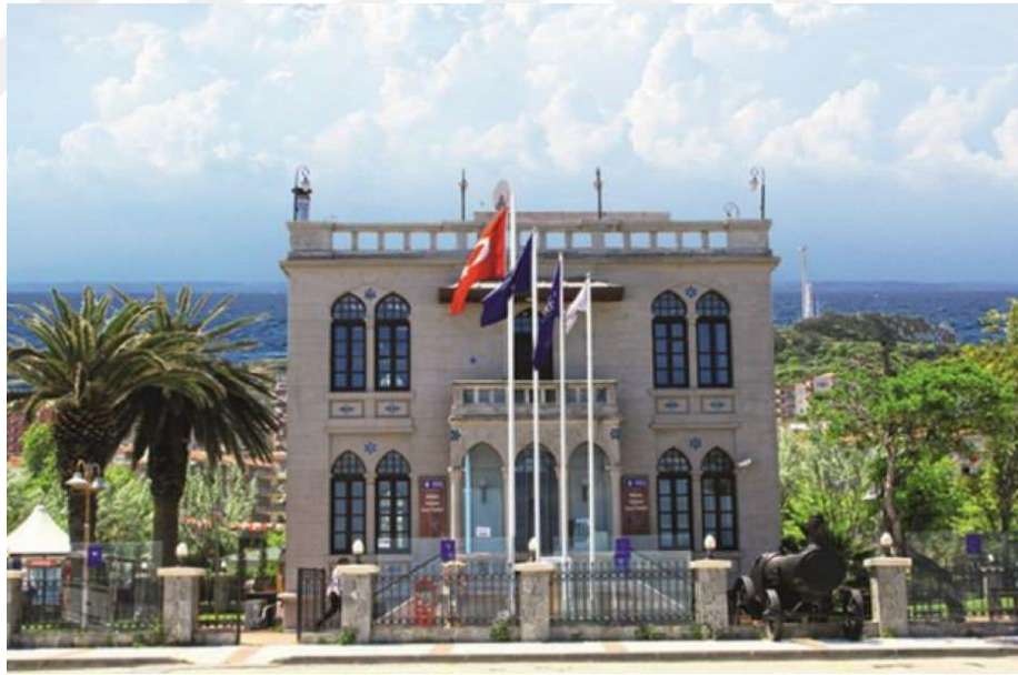
Şekil 3.16. Sosyal tesis işlevinde kullanılan Mudanya Gümrük İşletme Binası
