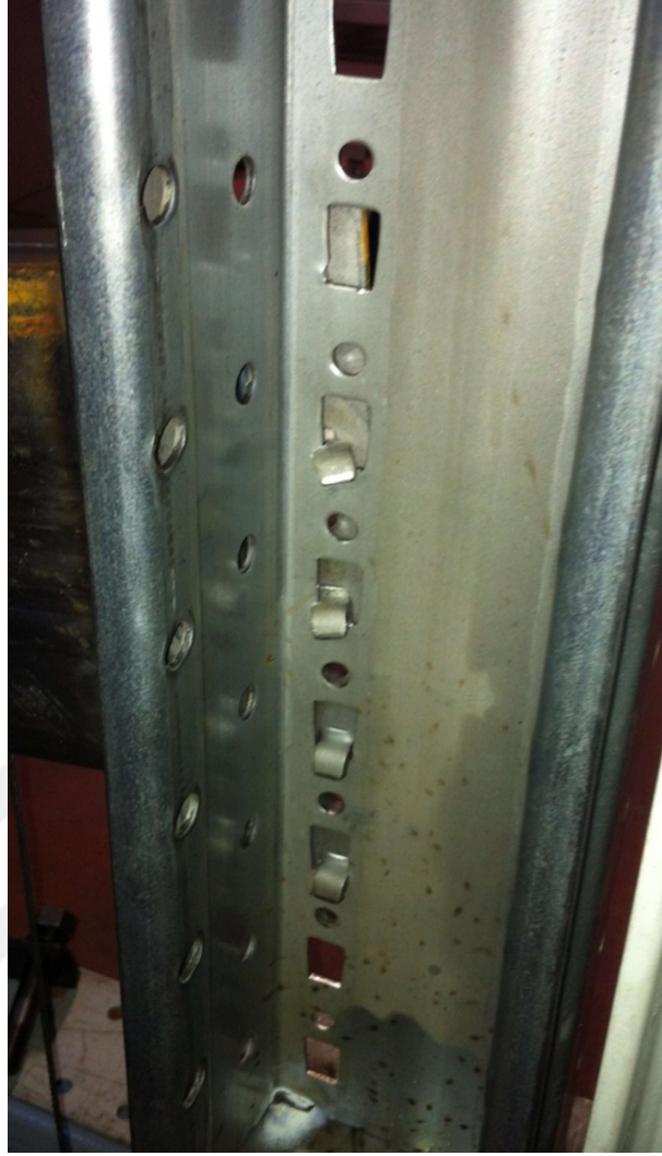
Şekil 4.3. Tırnakların dikey taşıyıcı içinden görünüşü
