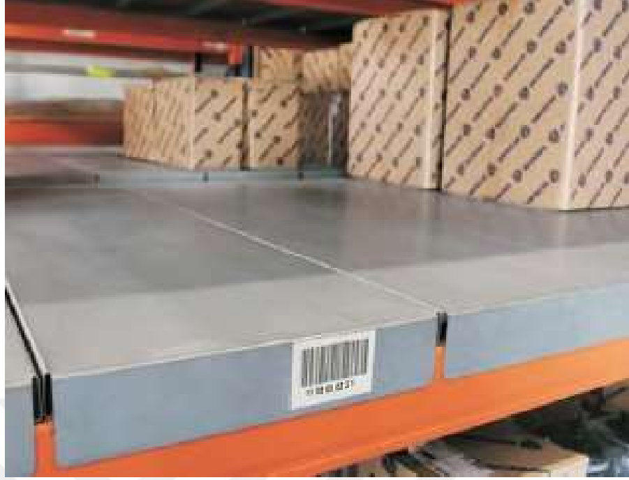
Şekil 3.18. Yatay taşıyıcı üzerine oturan bir düz tava raf görünümü
