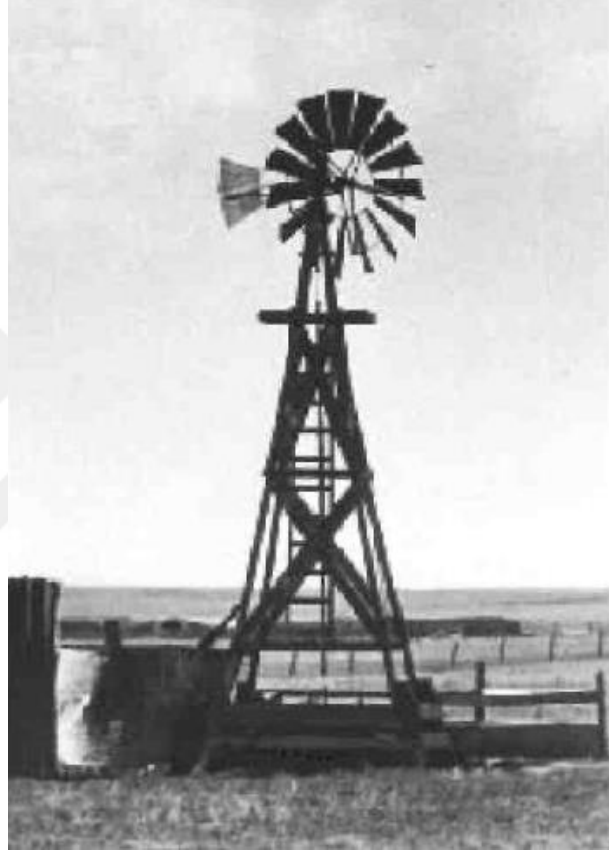
Şekil 1.10. Bir modern rüzgâr enerjisi su pompalama sistemi (newton.mec.edu)
