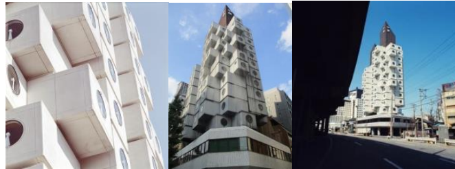
Şekil 2.4. Betonarme prefabrik yapı örneği. Nakagin Capsule Tower. Ginza, Tokyo, Japonya (Anonim 2019d)
