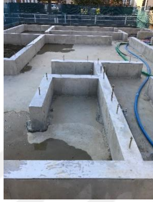
Şekil 3.37. Tamamlanmış temel uygulaması (Anonim 2019o)
