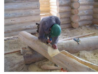
b) Kütük kanal ve çentiklerin açılması
