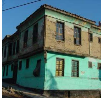
Şekil 2.10. Eskişehir’de geleneksel ahşap iskelet sistemli konut (Perker 2012)
