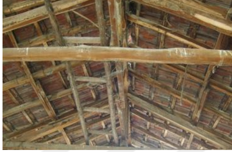
Şekil 2.33. Ahşap iskelet sistem çatı örneği (Perker 2012)
