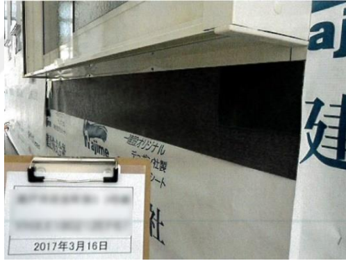
Şekil 3.54. Japonya örneği, pencere yalıtım uygulaması (Anonim 2017)
