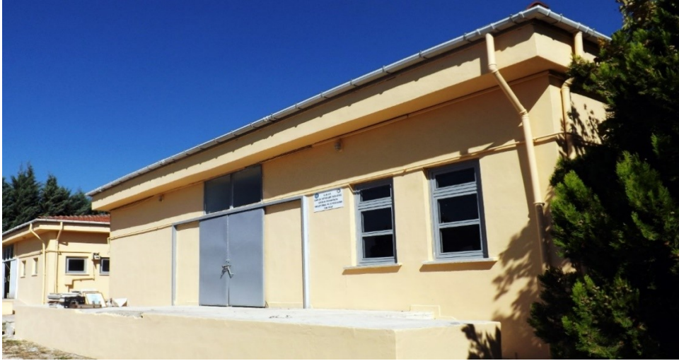
Şekil 3.3. Bursa Uludağ Üniversitesi Ziraat Fakültesi Bahçe Bitkileri Bölümü Soğuk Muhafaza Araştırma ve Uygulama Ünitesi.
