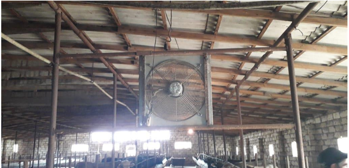
Şekil 2.1. Barınaklarda uygulanan mekanik havalandırma örneği
