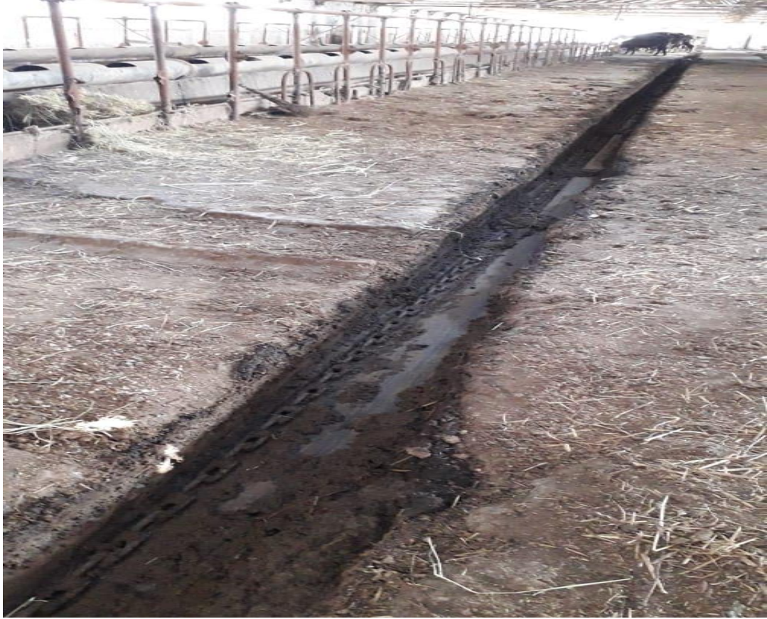
Şekil 4.8. Gübre temizleme sistemi
