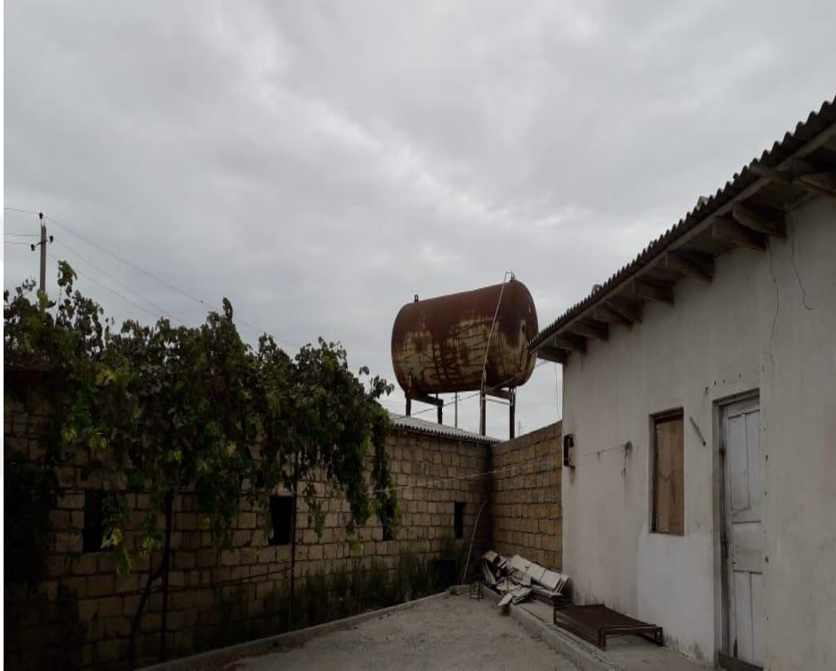
Şekil 4.12. İşletmelerde bulundurulan su deposu örneği
