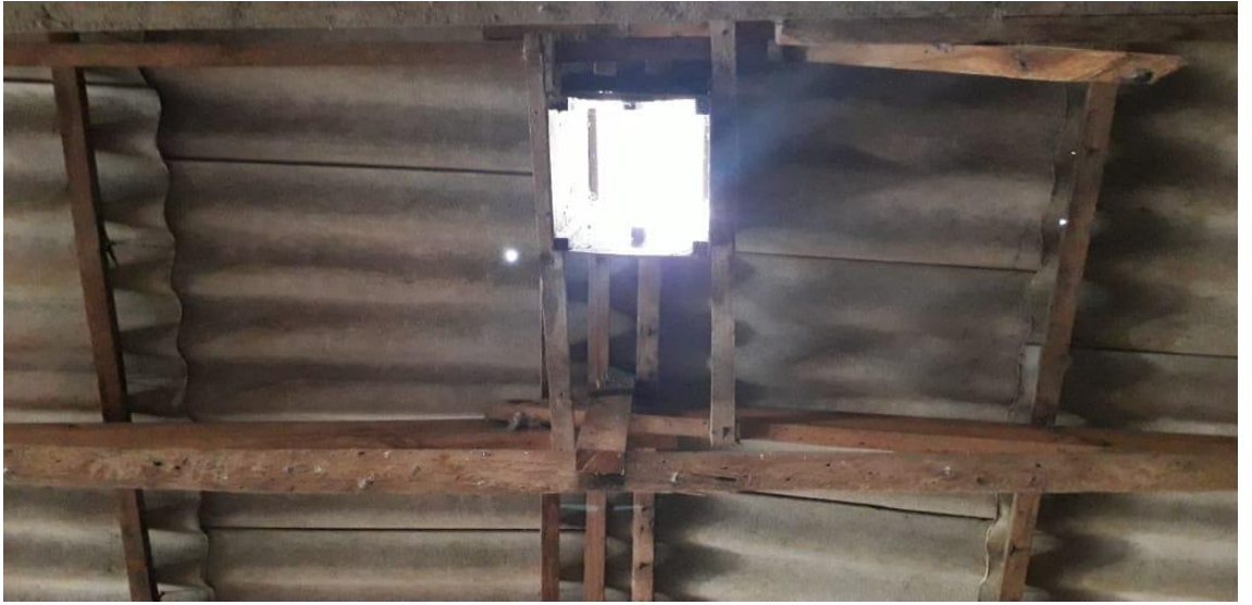
Şekil 2.2. Barınak çatısında bırakılan doğal havalandırma açıklığı
