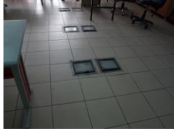
Şekil 4.283. Yıldırım Belediyesi Hacı Mehmet Zorlu Özel Eğitim Meslek Okulu atölye yerleşim düzenlerinin esnekliği için zeminde buat çözümleri
