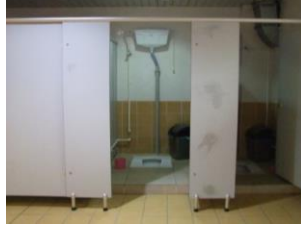
Şekil 4.286. Yıldırım Belediyesi Hacı Mehmet Zorlu Özel Eğitim Meslek Okulu yemekhane wc lavabo ve kabinleri
