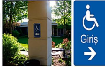
Şekil 4.53. Ortopedik engelli girişinin standartlara uygun tabela ile belirtilmesi (Özuslu ve ark. 2012)
