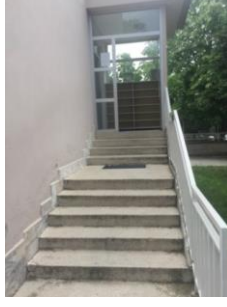
Şekil 4.142. İpek Özel Eğitim İş Uygulama Merkezi 1. Ek bina girişi
