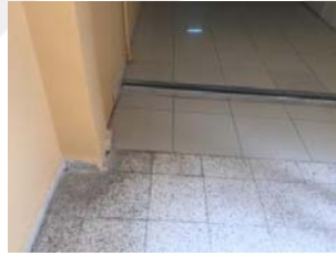
Şekil 4.182. Nilüfer Özel Eğitim Meslek Okulu Koridorda oluşan deformasyonlar
