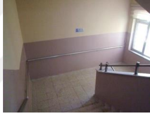
Şekil 4.97. Kayapa Özel Eğitim İş Uygulama Merkezi merdivende kullanılan malzeme ve ekipmanlar
