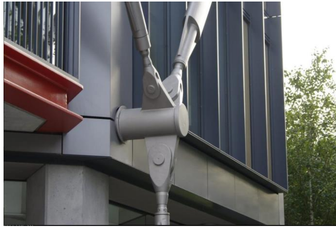
Şekil 2.4. Yapılarda paslanmaz gergi sistemi (Anonim 2016)
