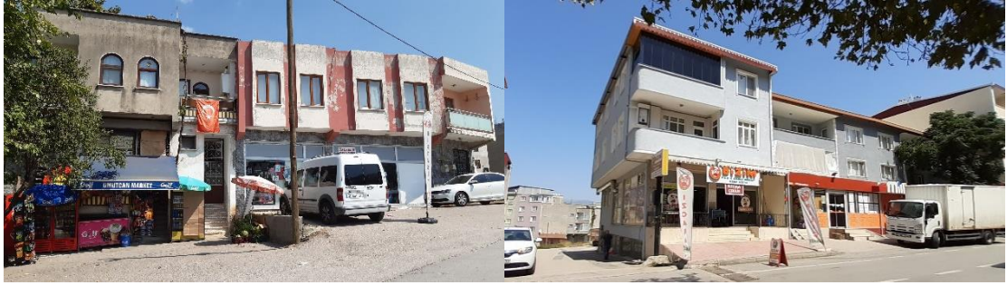
Şekil 3.18. Yiğitler Mahallesinde zemin katlarda yer alan mevcut dükkânlar
