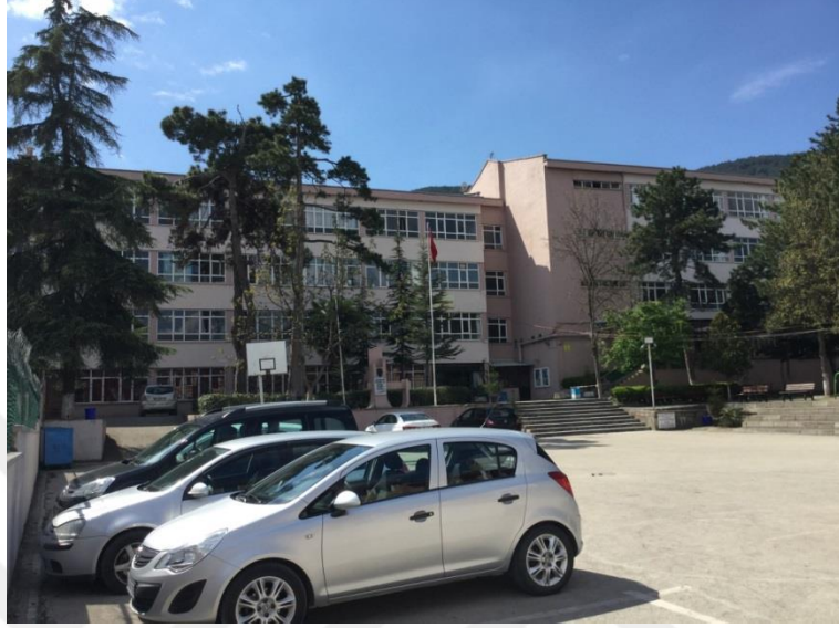
Şekil 3.42. Süleyman Çelebi Anadolu Lisesi kuzey cephesi
