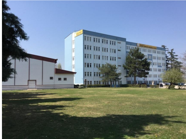
Şekil 3.31. Şükrü Şankaya Anadolu Lisesi doğu cephesi kapalı spor salonu ve bahçe
