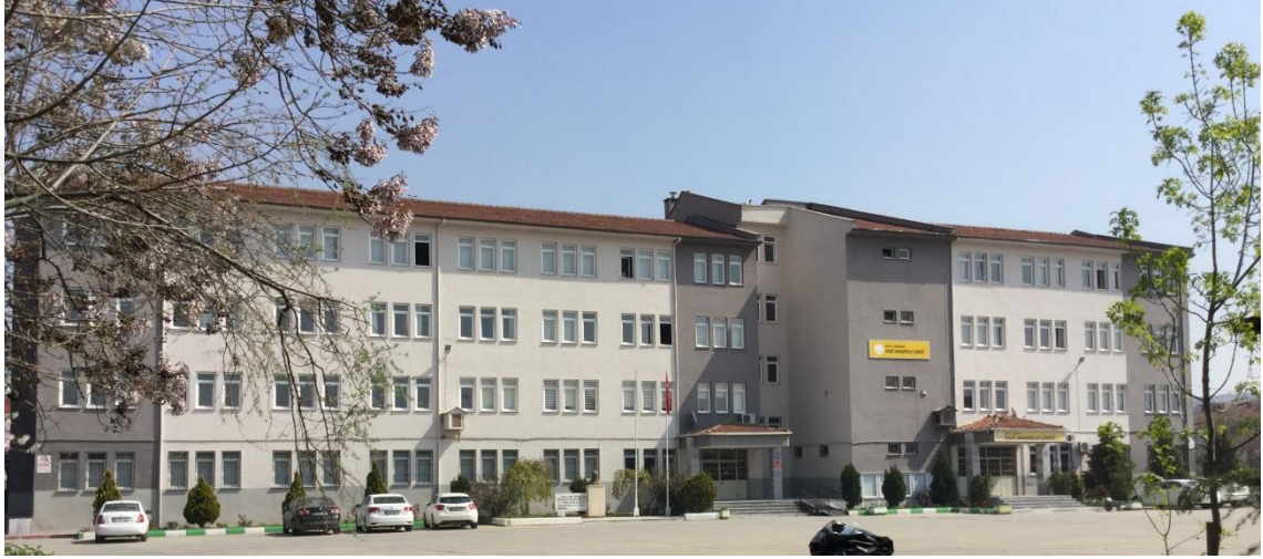
Şekil 3.9. Gazi Anadolu Lisesi güneybatı cephesi
