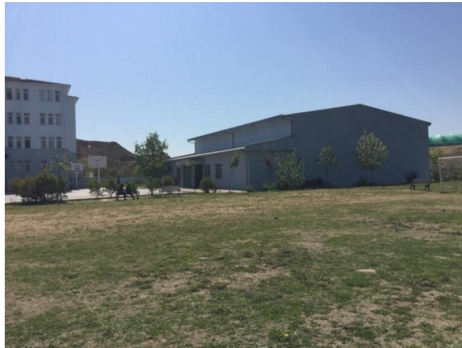
Şekil 3.60. Hasan Ali Yücel Anadolu Lisesi bahçe, kapalı spor salonu
