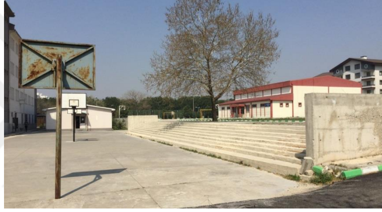
Şekil 3.19. Gazi Anadolu Lisesi basket sahası ve kapalı spor salonu
