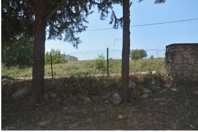
Şekil 4.29. Yıkılmış duvarlar (Orijinal)
