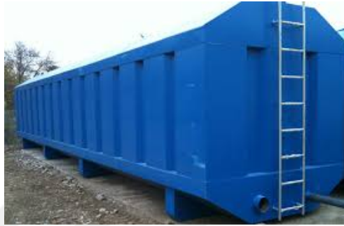
Şekil 2.6. Paket atıksu arıtma tesisi/tankı genel görünüşü
