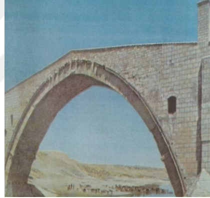
Fotograf-39 Malabadi Köprüsü
