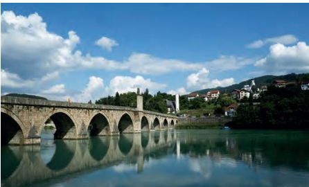
Fotoğraf-174 Sokullu Mehmet Paşa Köprüsü
