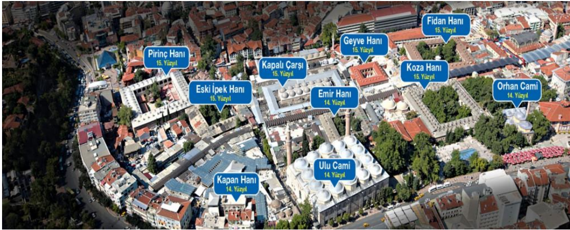
Şekil 4.2. Hanlar Bölgesi yapım tarihleri (Anonim 2019m)
