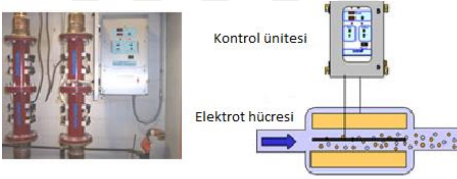
Şekil 2.1. Elektrolitik metal iyonizasyon sistemi (Yahya 1990)
