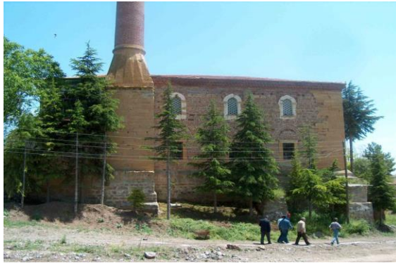
Şekil 2.8. Taş tuğla karışımı taşıyıcı kargir duvar.
