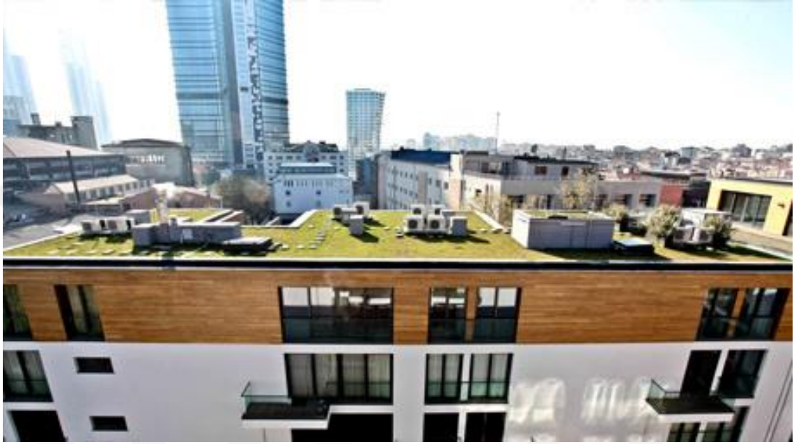
Şekil 3.8. Tekfen Bomonti Evleri yeşil çatı uygulaması ( http://i.dunyainsaat.com.tr/2/710/400/images/haberler/img53f12f1dc61cb.jpg?v=1408309200 ) (10.10.2018)
