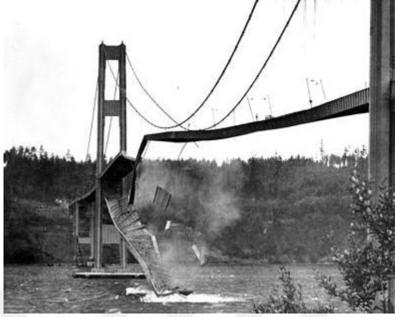
Şekil 2.10. Tacoma Narrows köprüsünün çöküş anı (Rao 2016)
