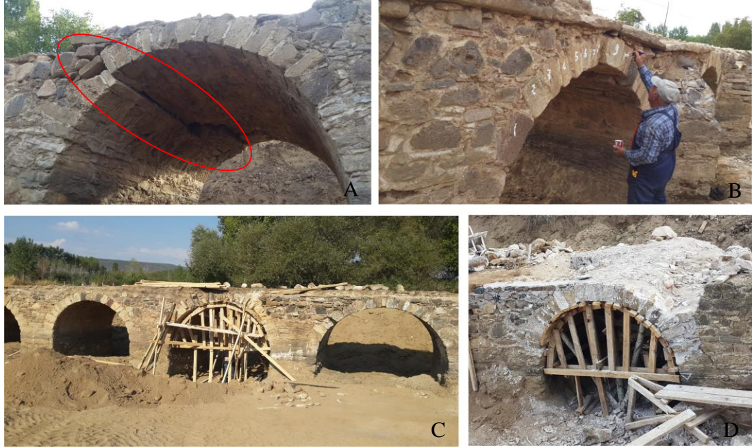
Şekil 3.136. Tarihi Dokuzgöz Köprüsü a) Zarar görmüş kemer b) Taşların numaralandırılıp c) Taşıyıcı iskele kurulumu ve taşların sökülmesi d) Kemerin yeniden yapılması
