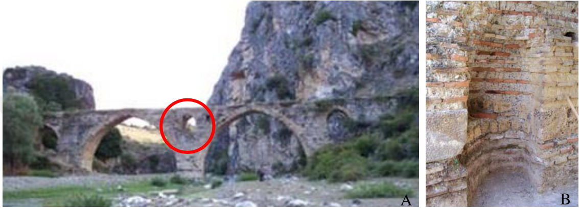
Şekil 3.92. Kurt Köprüsü a) Köprü görseli b) Hafifletme gözünün içindeki köprünün mihrabı (Halifeoğlu ve ark. 2013)
