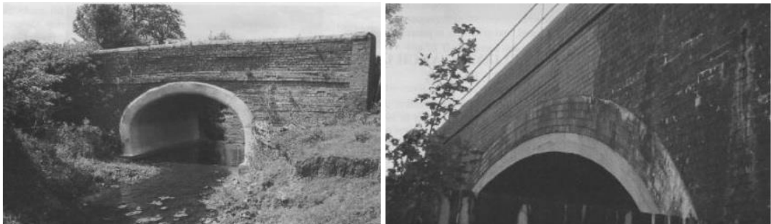
Şekil 3.143. Püskürtme beton uygulamaları (Page 1996, Beurman 2009)
