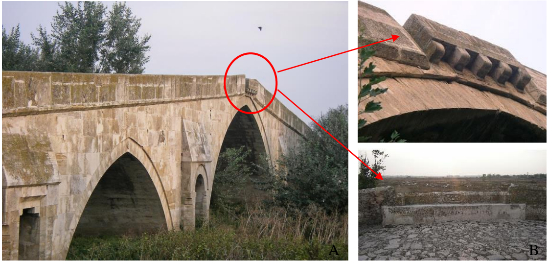
Şekil 3.72. Alpullu Sinanlı Köprüsü a) Köprü görseli b) Seyir terasının cepheden ve döşemeden görseli ( https://kantaratlas.blogspot.com/2015/03/alpullu-bridge.html?q=alpullu , 2018)
