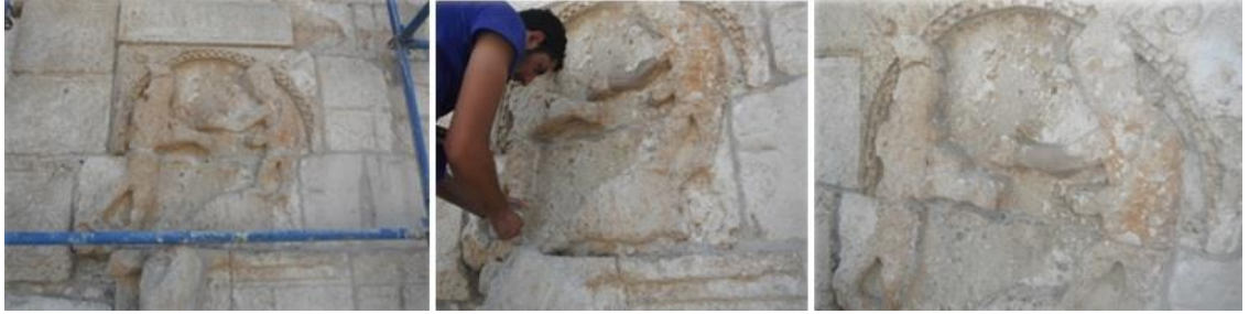
Şekil 3.127. Malabadi köprüsündeki heykel konservasyonu (Sert ve ark. 2016)
