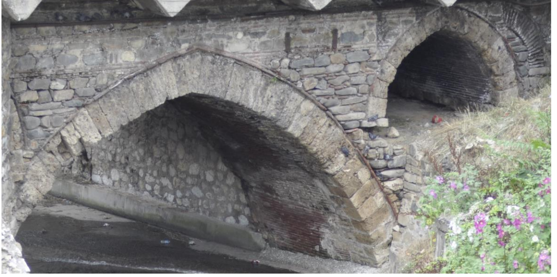
Şekil 3.29. Tarihi Tatarlar Köprüsü, Bursa. Kemer içlerinde ve tempan duvarda tuğla kullanımı
