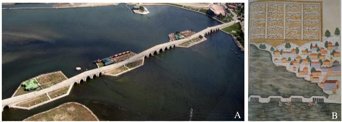
Şekil 3.16. Büyükçekmece (Mimar Sinan) Köprüsü (16. yy.), İstanbul a) Köprü görseli ( http://www.bcekmece.bel.tr/tr-tr/Buyukcekmece/Ilcemizde-Yasam/TarihiYerler/Sayfalar/Buyukcekmece-Koprusu.aspx , 2018) b) Nakkaş Osman'ın Büyük Çekmece Köprüsü tasviri (Develi 2002)
