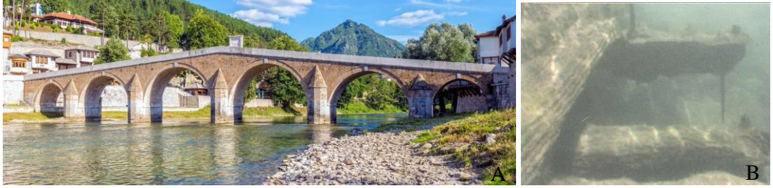
Şekil 3.19. Konjic Köprüsü (1682), Bosna Hersek a) Köprü görseli b) Temelinde kullanılan ahşaplar (Sert ve ark. 2009)
