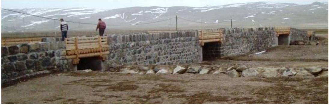
Şekil 3.48. Tarihi Pulur Köprüsü, Erzurum. Köprü açıklıklarını geçmek amacıyla kullanılan ahşap kirişler (Yılmaz ve Sert 2012)
