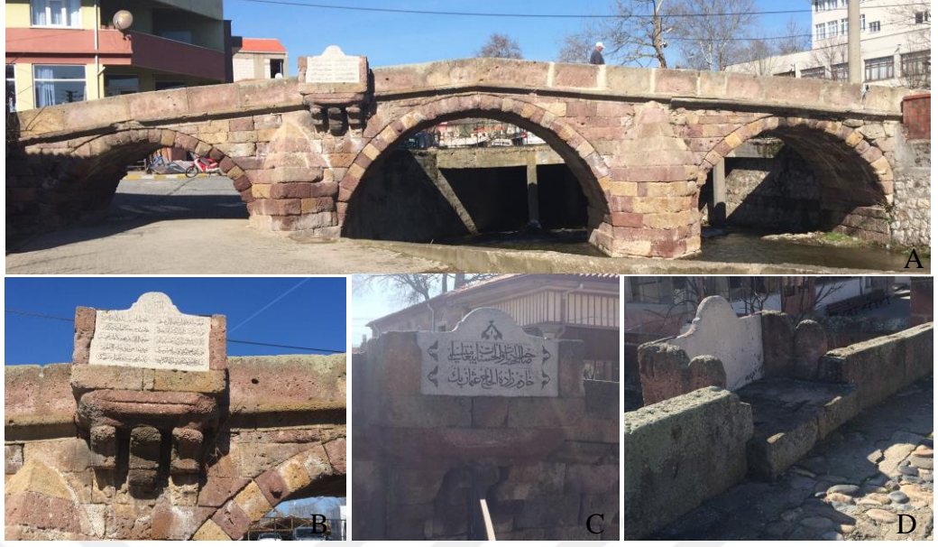
Şekil 3.68. Karşıyaka (Bayramiç) Köprüsü, Çanakkale a) Köprü görseli b) Kitabenin memba yönünden görünüşü c) Mansap yönünden görünüşü d) Döşemeden görünüşü
