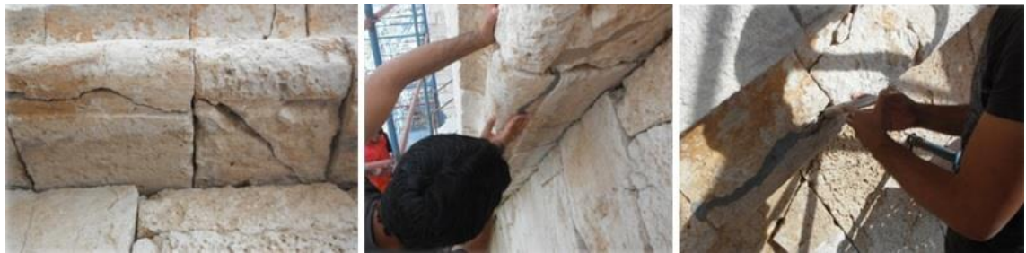
Şekil 3.124. Malabadi köprüsündeki mikroenjeksiyon uygulaması (Sert ve ark. 2016)
