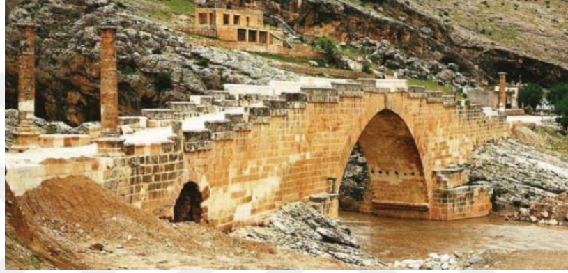
Şekil 3.37. Sivri kemer kullanımı, Cendere Köprüsü, Adiyaman (Alkan ve ark. 2011)
