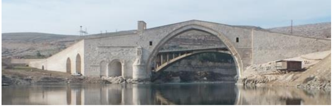
Şekil 3.14. Malabadi Köprüsü (1147), Diyarbakır (Halifeoğlu ve ark. 2017)
