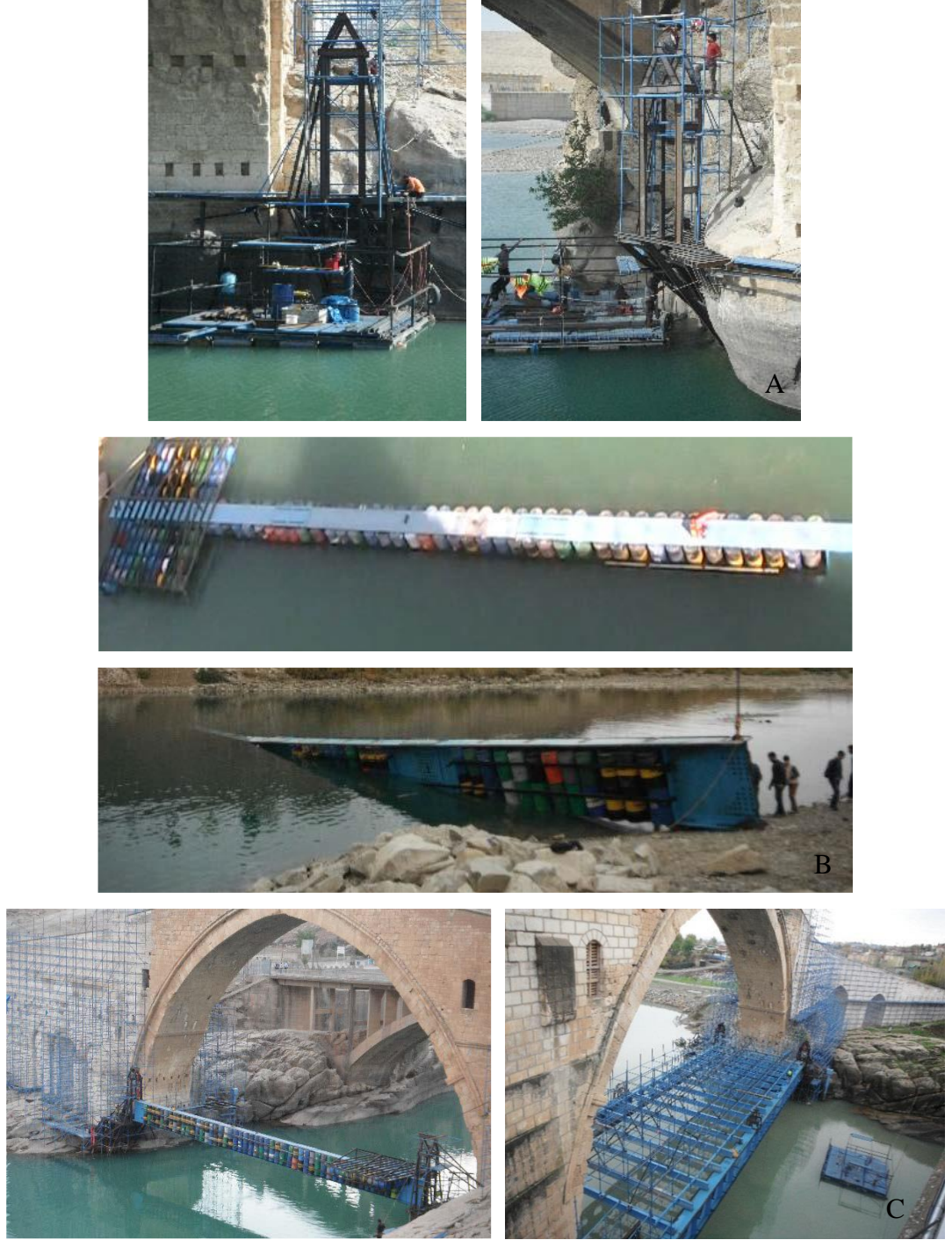
Őekil 3.45. Ana kemerde iř iskelesinin kurulum ařamaları a) Vin kurulumu b) Profillerin suya bırakılması c) I kiriřlerin yerleřimi ve iskele (Halifeoęlu ve ark. 2017)
