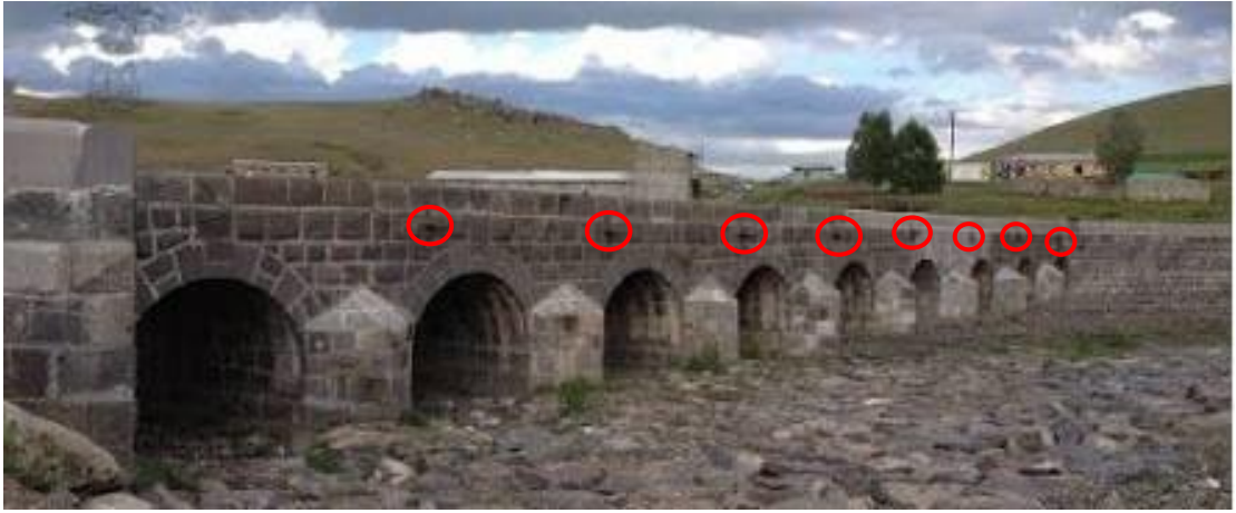
Şekil 3.97. Nebi Çayı (Hanı) Köprüsü çörtlenleri, Erzurum ( http://iq.geoview.info/nebi_cay%C4%B1_koepruesue,92239478p , 2018)
