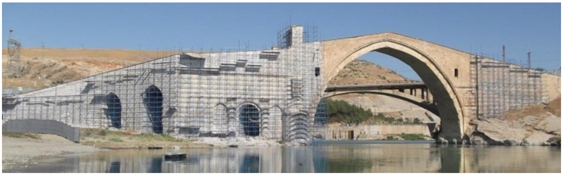
Şekil 3.120. Malabadi köprüsünde çimento sıvanın temizlenmesi (Sert ve ark. 2016)
