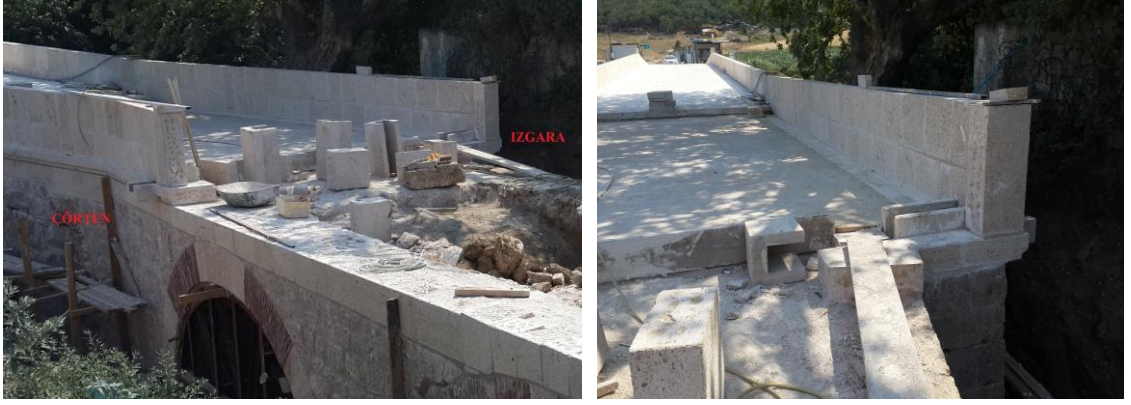
Şekil 3.148. Nilüfer Hatun Köprüsünde yapılan yeni yonu taşı döşeme kaplaması yapılması ve ızgara-çörten çözümlenmesi
