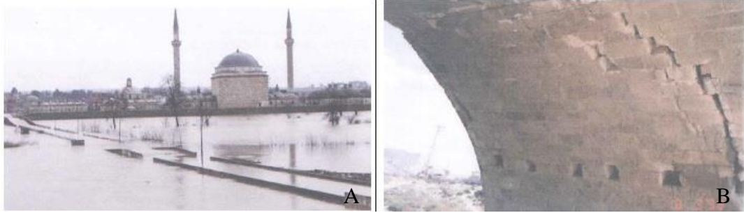
Şekil 3.107. Afetlerin zarar verdiği köprüler a) Edirne'deki tarihi Yalnızgöz Köprüsü 2007 yılında meydana gelen selde sular altında kalmıştır. b) Adana'daki tarihi Misis Köprüsünün 1998 depreminde kemerleri ciddi şekilde hasar almıştır (Sert ve ark. 2009)
