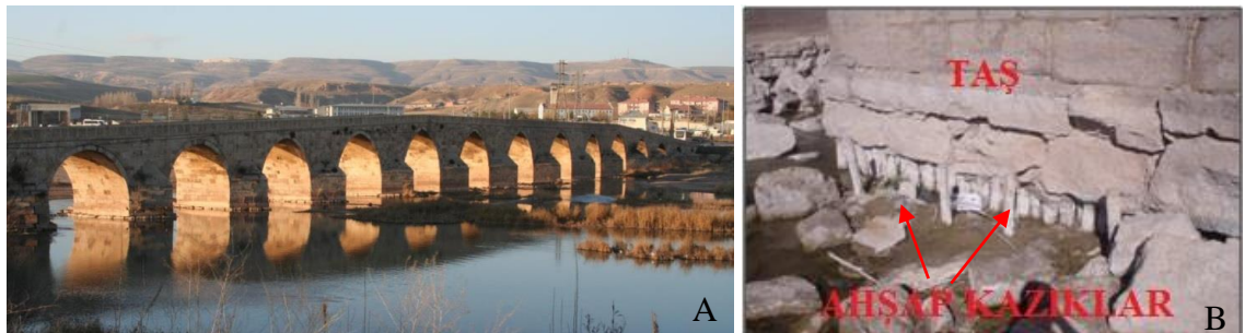
Şekil 3.15. Kesikköprü, Sivas (13. yy.) a) Köprü görseli b) Temelindeki ahşap kazıklar (Sert ve ark. 2009)
