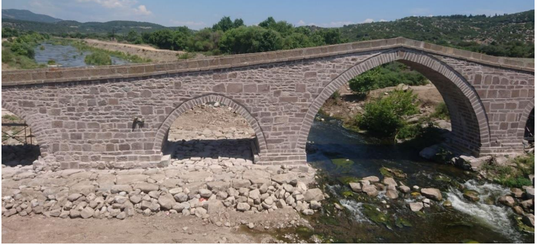
Şekil 3.116. Behramkale Köprüsündeki taş tahkimat çalışmasının bir bölümü
