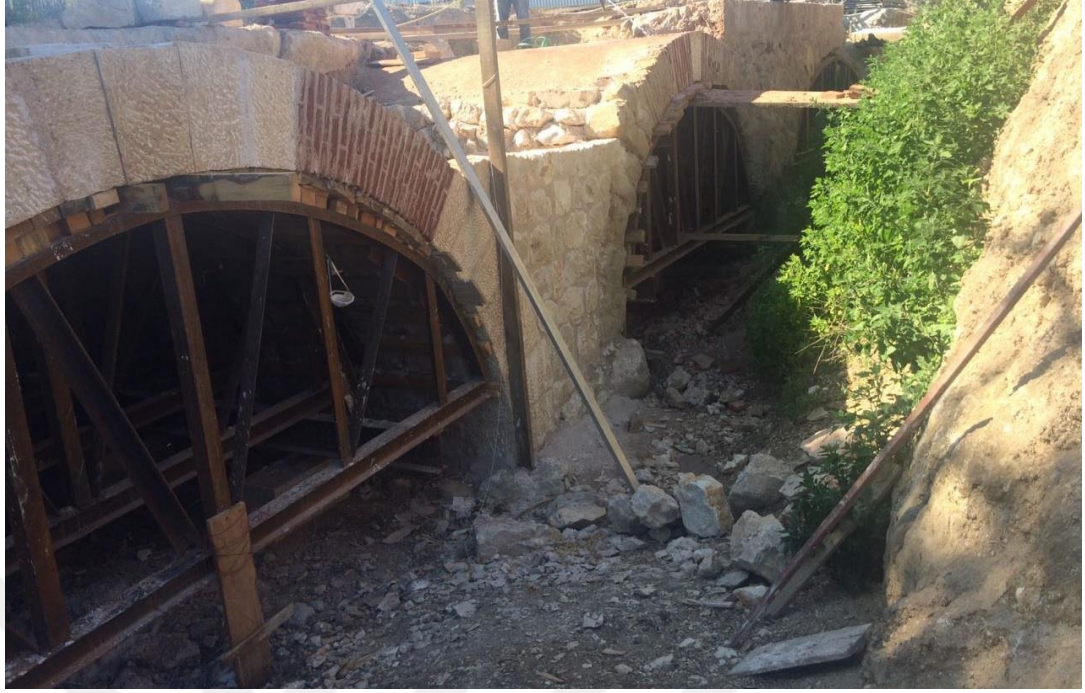
Şekil 3.42. Tarihi Nilüfer Hatun Köprüsü taşıyıcı iskeleler
