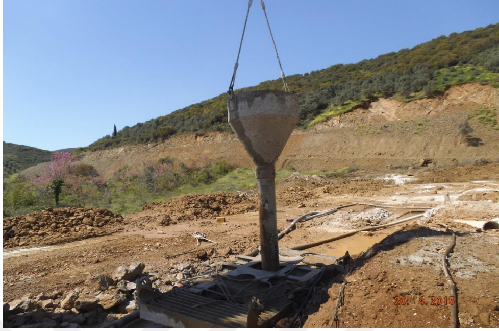
Şekil 3.34. Bentonit ile dolu hendeğe tremie borusunun yerleştirilmesi
