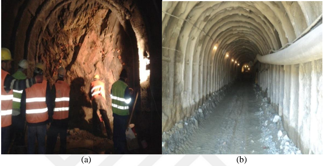
Şekil 3.15. (a) Tünel kazısı (b) Destekleme çalışmaları
