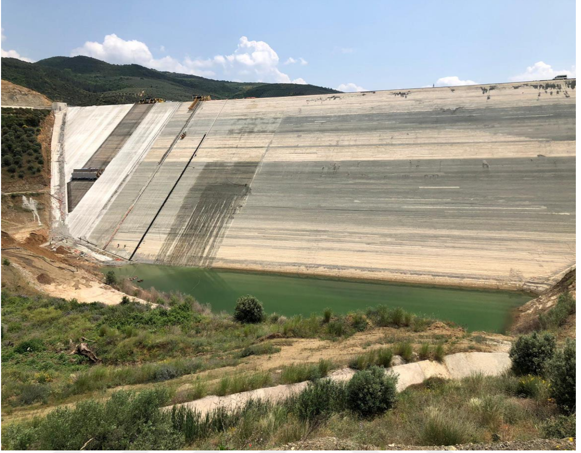
Şekil 3.22. Yapım aşaması genel görünüm
