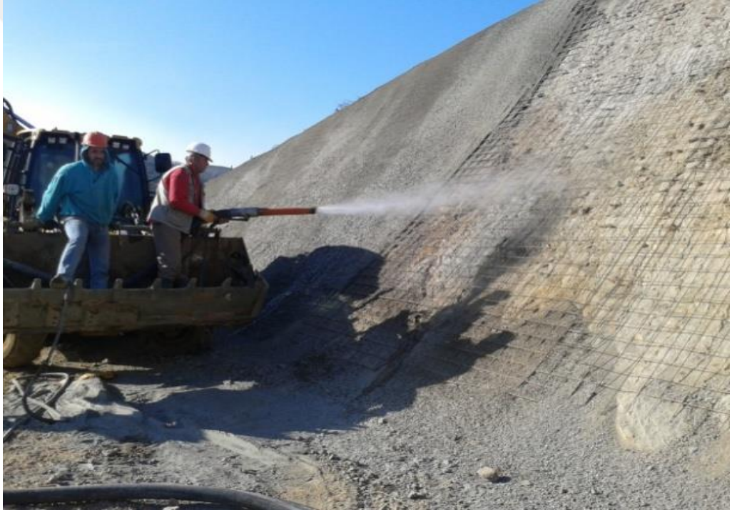
Şekil 3.14. Püskürtme betonu uygulaması
