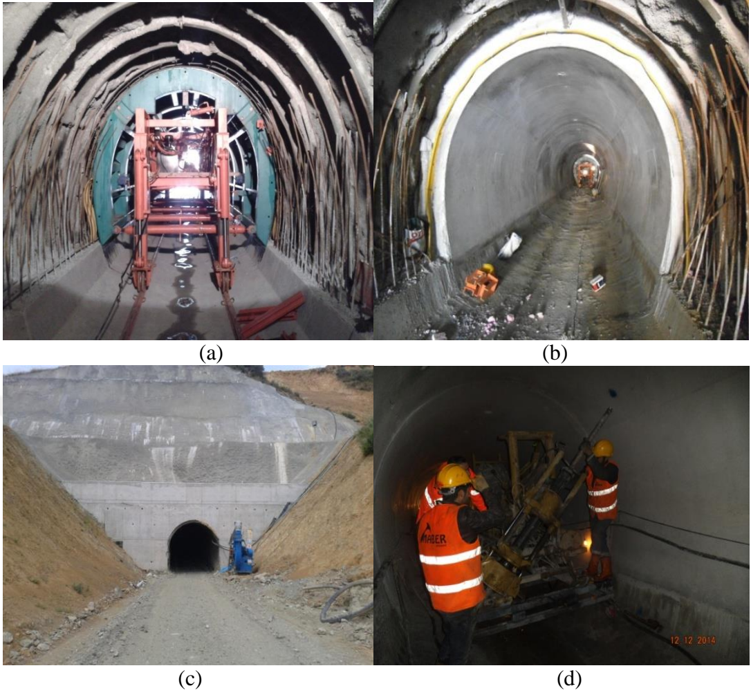
Şekil 3.16. (a)-(b) Tünel beton kaplama ve (c)-(d) Tünel enjeksiyon çalışmaları
