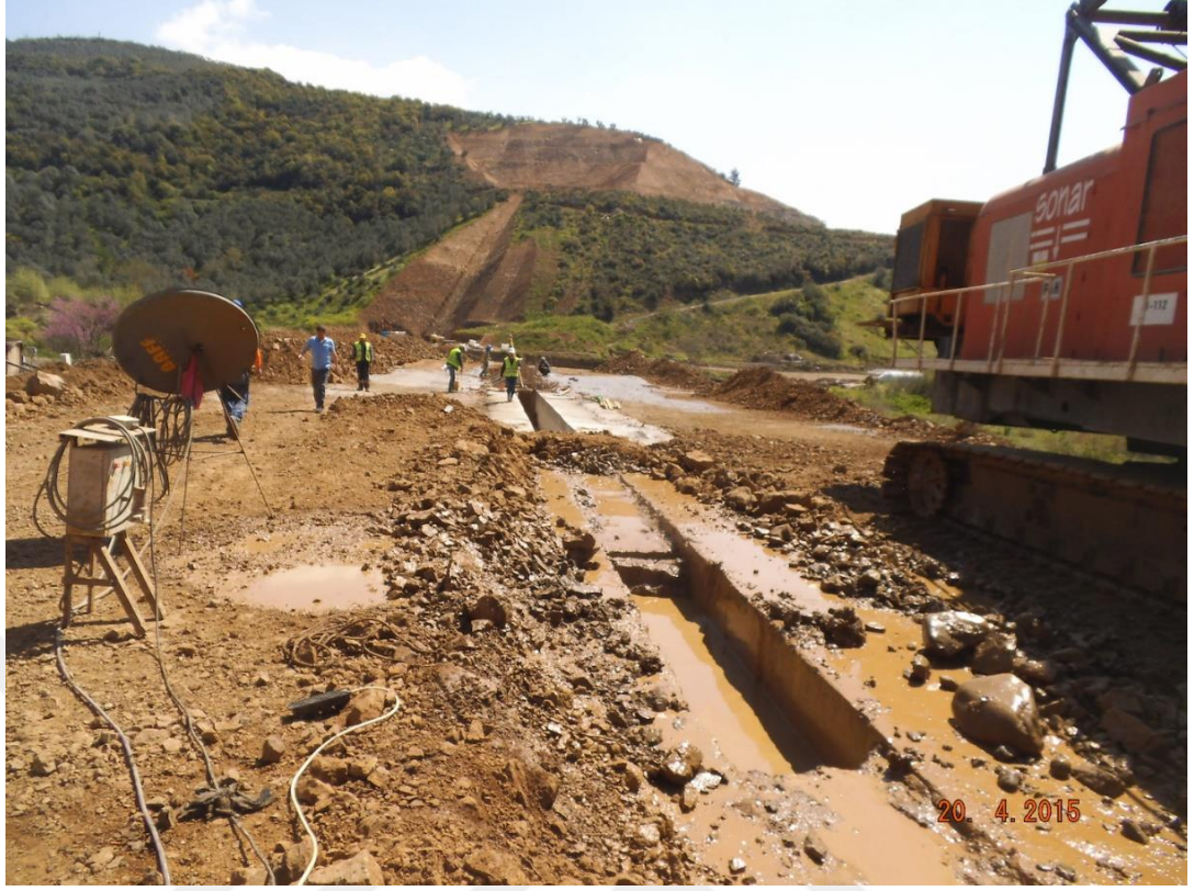
Şekil 3.33. Hendeklerin bentonit ile desteklenmesi
