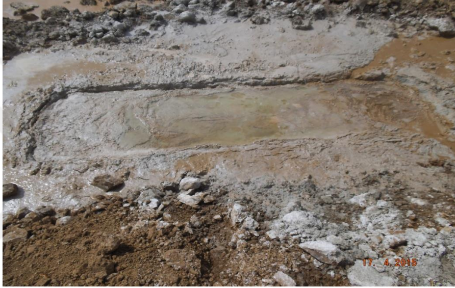
Şekil 3.36. Tamamlanmış slurry trench imalatı
