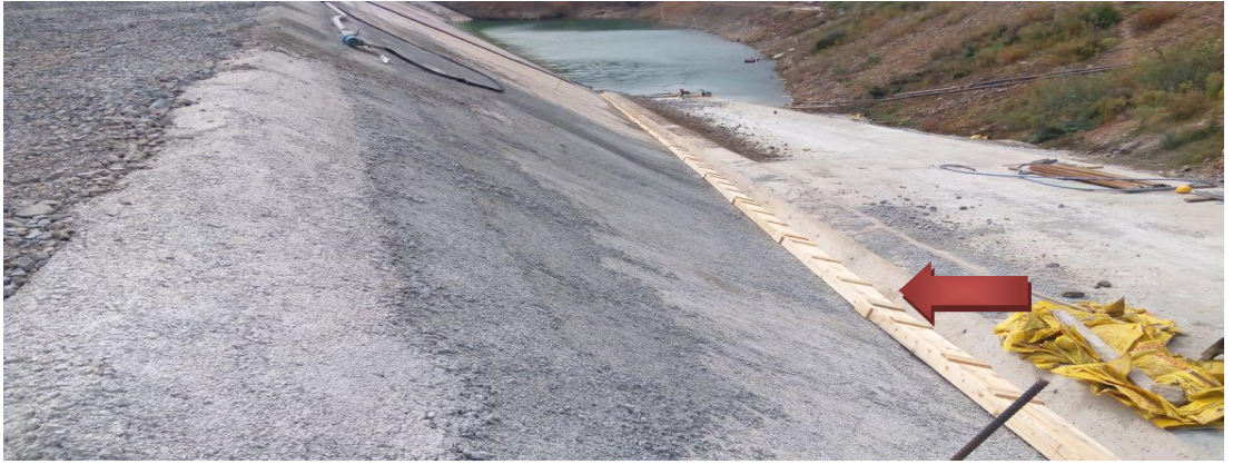
Şekil 3.23. Bakır su tutucuların ahşap takozlarla korunması
