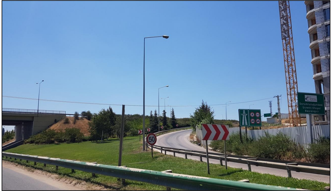
Şekil 4.32. 3. Bölge yol güzergâhında köprü girişinde yetersiz bitkilendirme çalışması (Sevgi YILMAZ, 2019-Orijinal)
