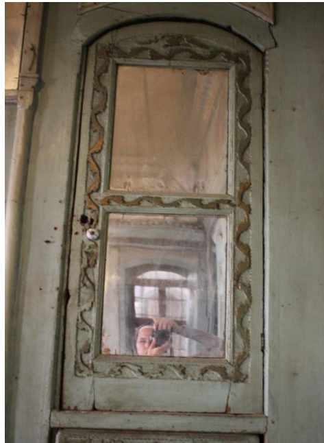
Şekil 76. Batı duvarının dolap kepenkleri (Acam arşivi 2019)
