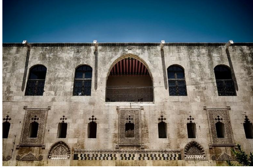
Şekil 50. Gazali Evi'nin avlu kuzey cephesi (Maraashi 2019)
