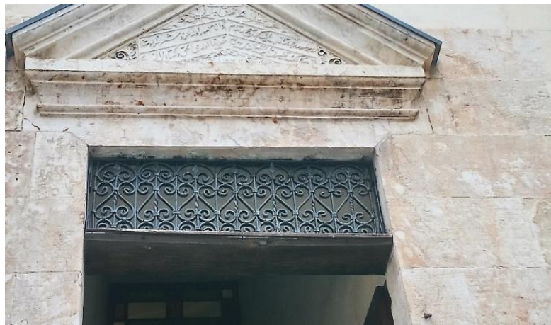
Şekil 120. Bina giriş kapısı üzerindeki süslü demir korkuluk (Acam arşivi 2019)
