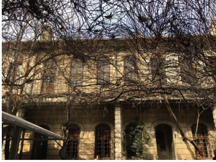
Şekil 97. Abdülkadir Kimya Evi avlu cephesi (Acam arşivi 2018)
