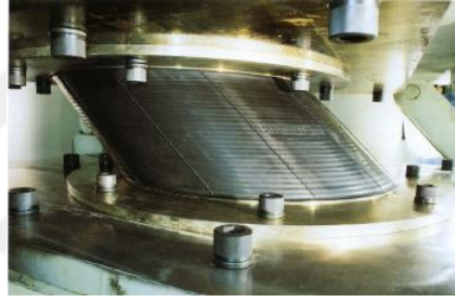
Şekil 2.17 Yüksek sönümlü kauçuk izolatör (Yücesoy 2005)
