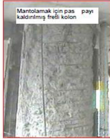
Şekil 2.10 Fretli kolonlara mantolama işlemi (Atmaca 2013)
