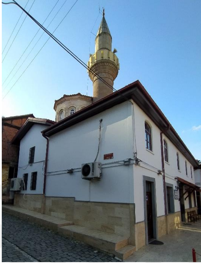
Şekil 4.42. Kudrettin Cami doğu cephesi
