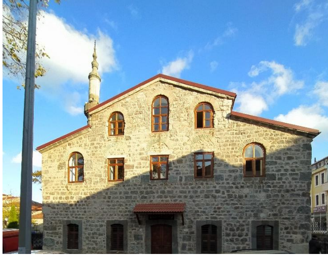
Şekil 4.20. Fatih Cami batı cephesi, 2019
