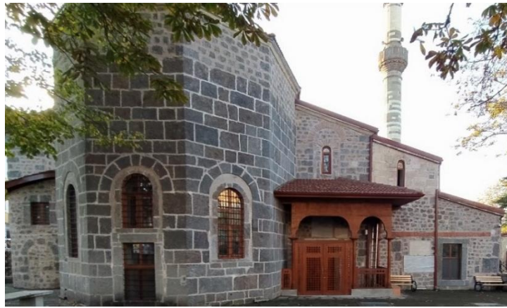
Şekil 4.21. Fatih Cami doğu cephesi, 2019
