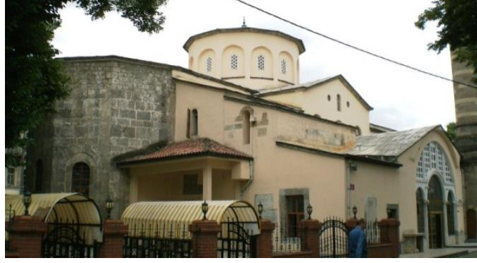
Şekil 4.3. Fatih Cami restorasyon öncesi kuzey cephesi (Anonim 2018)
