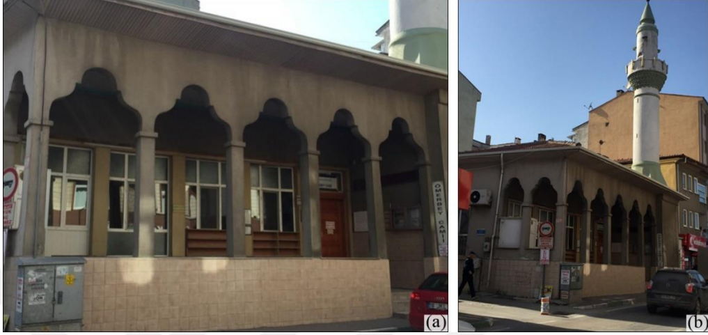
Şekil 3. 76. Ömerbey Camisi (a) kuzey cephesi son cemaat yeri, (b) doğu görünüşü (2016)
