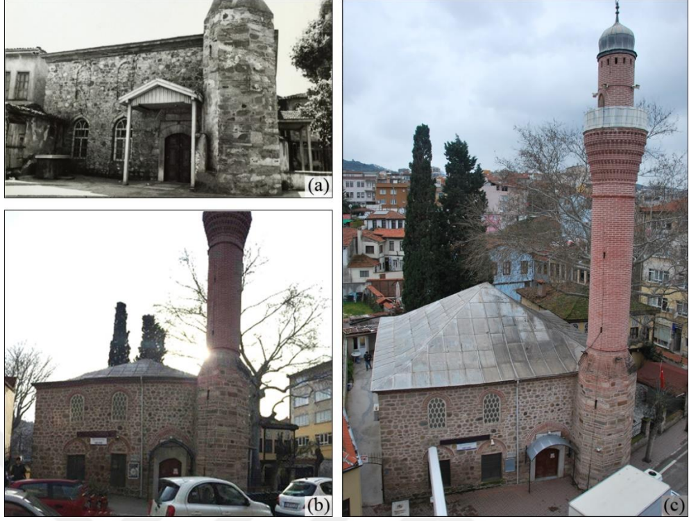
Şekil 3. 45. (a) Eski Cami'nin 1976 yılına ait fotoğrafı. (B.K.V.K.B.K. Arşivi 2016), (b) Eski Cami doğu cephesi (2016), (c) Eski Cami girişi ve minaresi (2016)
