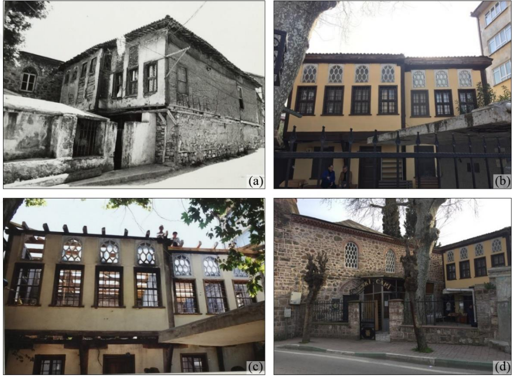
Şekil 3. 48. (a) Eski Cami meşrutası 1976 yılı (BKVKBK arşivi 2016), (b) Caddeden görünüm-kuzey cephesi (2016), (c) Yangın sonrası restorasyon aşaması (B.K.V.K.B.K. arşivi 2016), (d) Eski Cami kuzey cephesi ve Eski Cami meşrutası.
