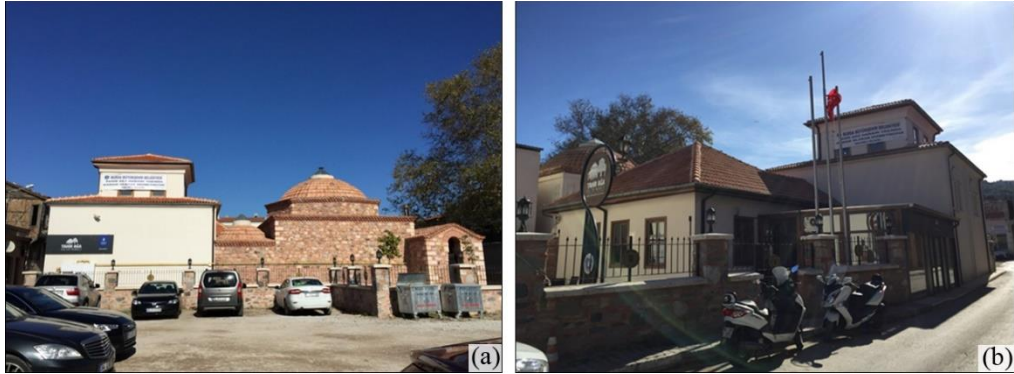
Şekil 3. 88. Tahir Ağa Hamamı (a) güney görünüşü, (b) kuzeybatı görünüşü
