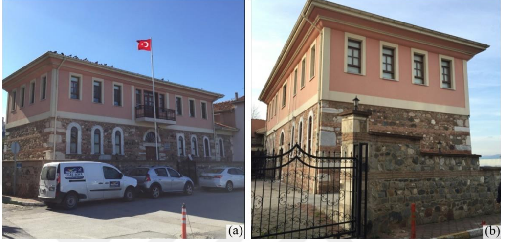
Şekil 3. 93. Kaymakamlık binası (a) Kuzeydođu cephesi, (b) Güneydođu cephesi
