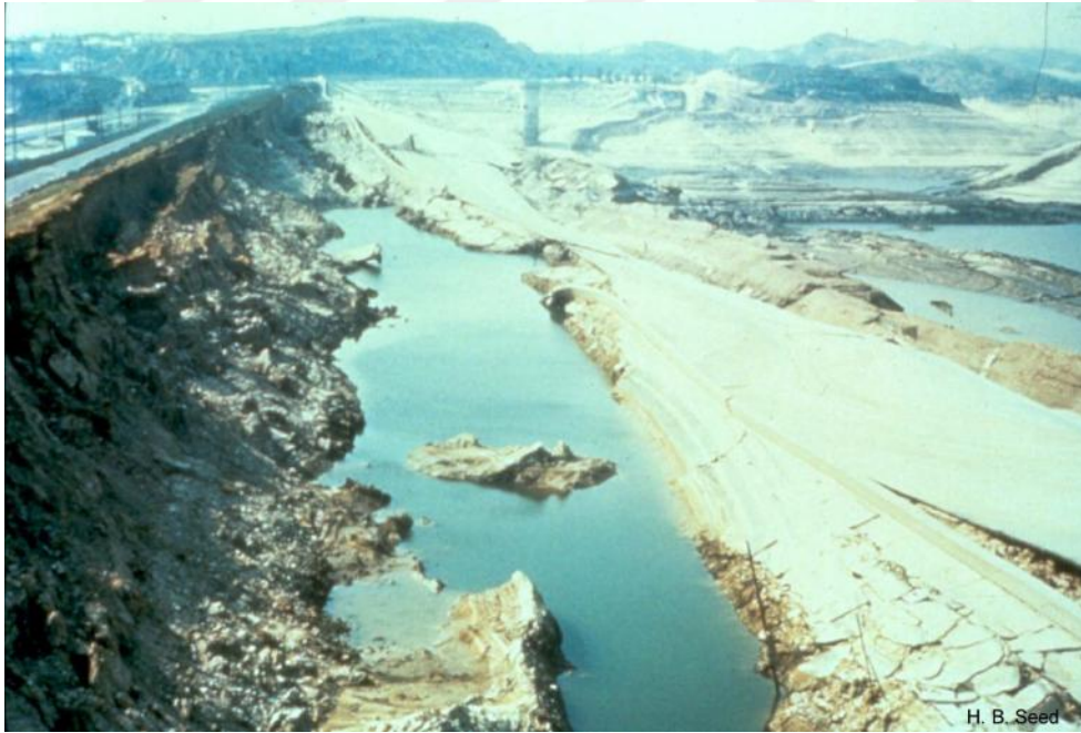
ekil 2.7. 1971 yılında gerçekte en The Lower an Fernando depremi sırasında olu an akma göçmesi
