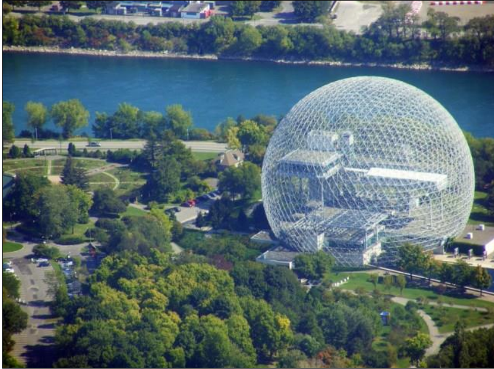
Şekil 4.10. Amerikan Pavyonu, Buckminster Fuller, Montreal. Expo 1967 için tasarlanan jeodezik kubbe, temel geometrik formlardan olan küre biçimindedir. (Anonim 2019b)
