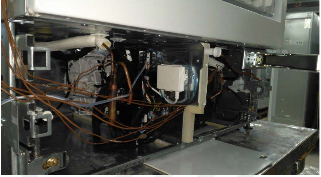
Şekil 3.33. Makine odasındaki ısıl çift bağlantısı
