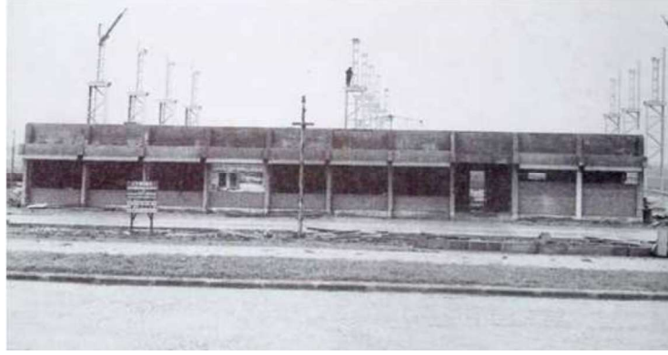
Şekil 3.17. 1971 ÇEMTAŞ İdari Bina ve Çelikhane İnşaata (Kuter 2017'den alınan ÇEMTAŞ Arşivi)
