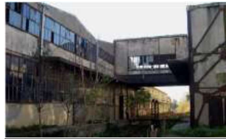
Şekil 2.10. SEKA I. ve II. Kağıt Fabrikaları ve Köprü Bağlantısı (Güzel 2010)
