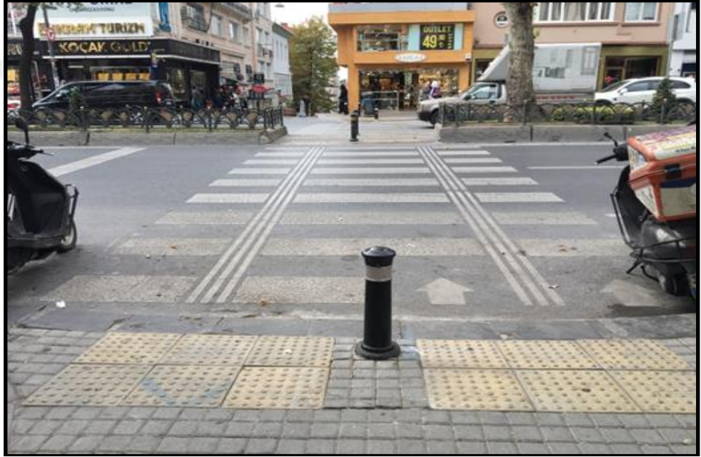
řekil 4.98. Fevzipařa Caddesi'ndeki beton kptař zemin kaplaması ve kılavuz iz rnekleri (Pınar ZKAN, 2019- Orijinal)
