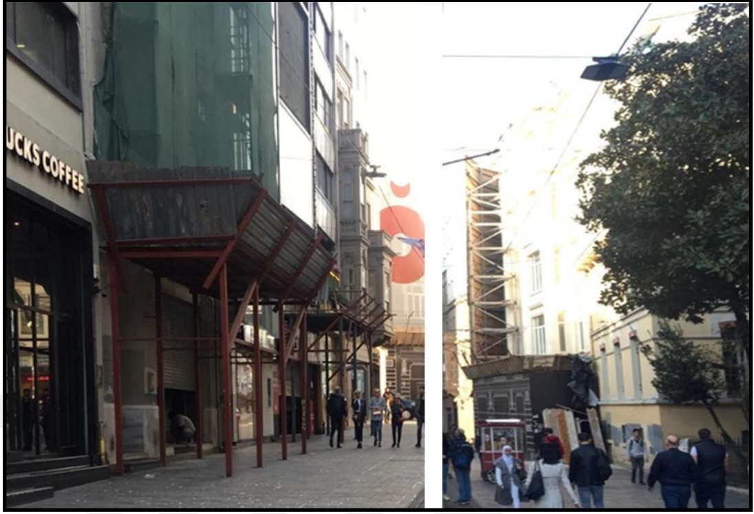
Şekil 4.7. İstiklal Caddesi’de bulunan inşaat alanları ile caddeyi birbirinden ayıran sınırlama paneli örnekleri (Pınar ÖZKAN, 2019-Orijinal)
