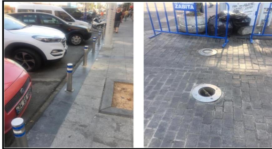
Şekil 4.153. 58. Bulvar Caddesi’ndeki çelik duba ve pistonlu duba sınır elemanları (Pınar ÖZKAN, 2019- Orijinal)
