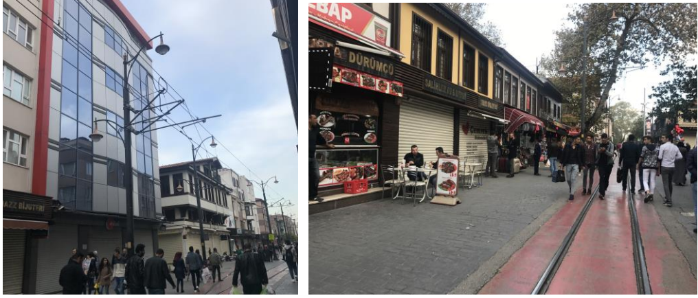
Şekil 4.12. Cadde cephesindeki yapıların cephe materyalleri
