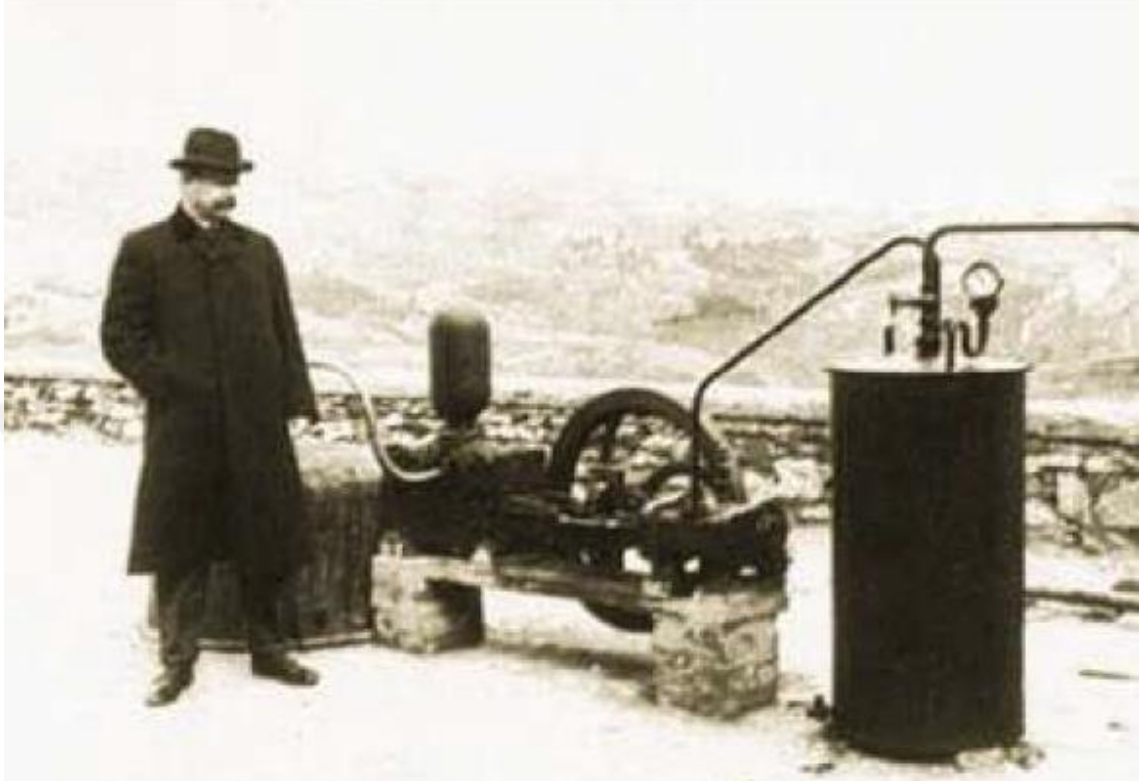
Şekil 4.1: İlk Jeotermal Güç Santrali, 1904, Larderello, İtalya. Jeotermal Buhardan Elektrik Enerjisi Üretme Denemesinde Kullanılan Motor, Mucit Prens Piero Ginori Conti İle Birlikte
