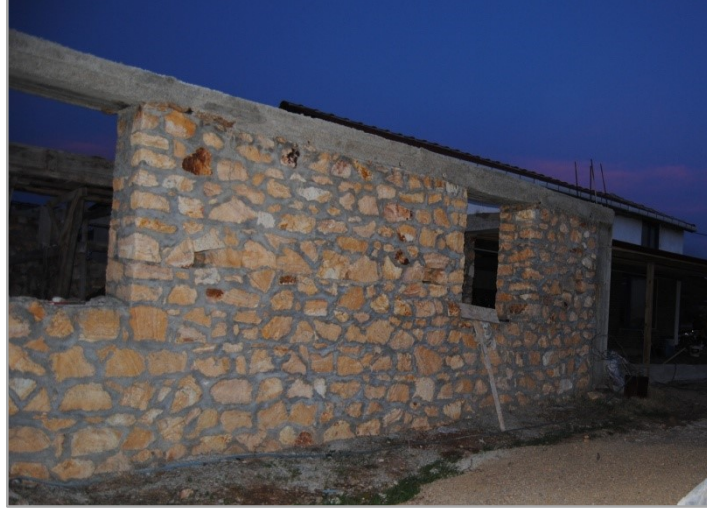
Şekil 4.7. Yerleşkedeki karma yapılı konut yapısı (Bartu 2019-2020 arşivinden alınmıştır)
