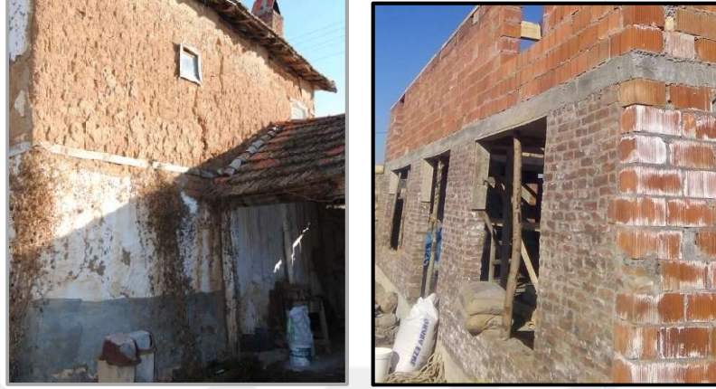
Şekil 4.25. Ahmetçeli hımış konut yapısı ve Sevinç Abla tuğla yığma atölye yapısı (Bartu 2019-2020 arşivinden alınmıştır)
