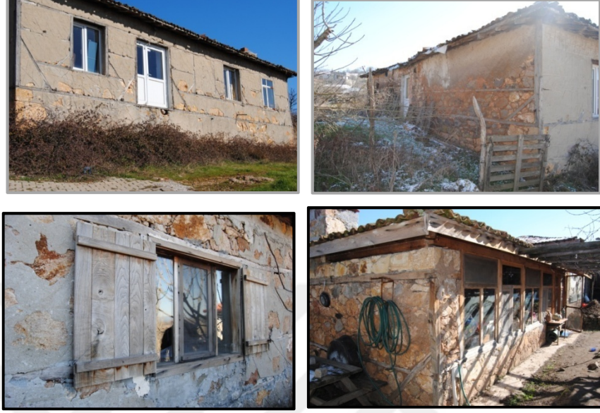
Şekil 4.38. Muratlar konut yapısı taş yığma konut yapısı ve Bayramiç/Yeniköy taş yığma mutfak yapısı (Bartu 2019-2020 arşivinden alınmıştır)
