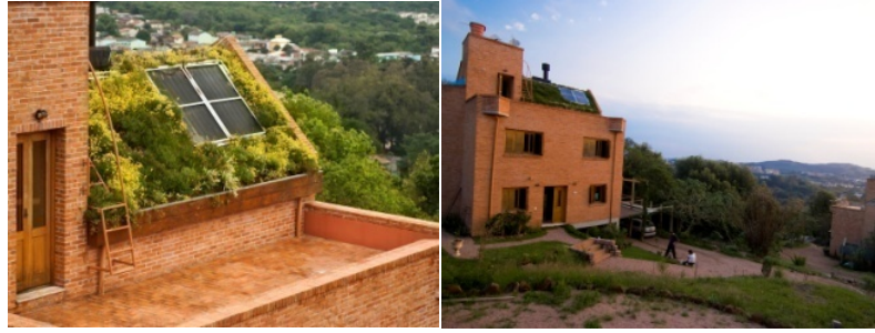
Şekil 2.15. Condomínio Ecoovila konutlarının bakıya göre konumlanmış güneş panelleri (Anonim 2019y)
