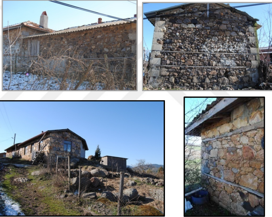
Şekil 4.37. Muratlar köyündeki taş yığma konut yapısı ve Bayramiç/Yeniköy konut yapısı (Bartu 2019-2020 arşivinden alınmıştır)
