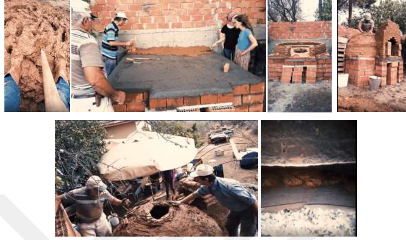
Şekil 4.6. Sevinç Abla'nın çiftliğinde tuğla fırın yapım uygulaması (Sevinç Özkaya 2017 arşivinden alınmıştır)
