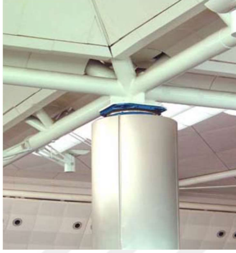
Şekil 2.16. Atatürk havalimanı sürtülmeli sarkaç izolatör örneği
