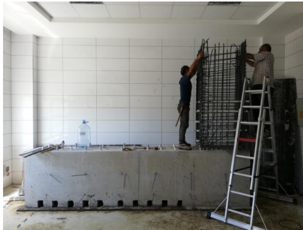
Şekil 3.8. Güçlü kolon donatı montajı
