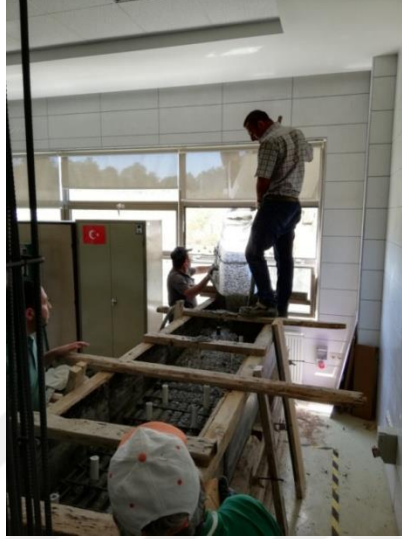
Şekil 3.7. Güçlü kirişin beton döküm işlemi
