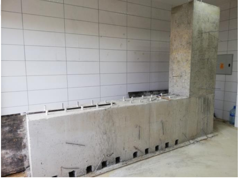
Şekil 3.10. Deney Düzeneğinin kurulacağı betonarme yapının son hali
