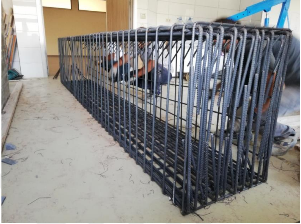
Şekil 3.4. Güçlü kirişin donatı detayı
