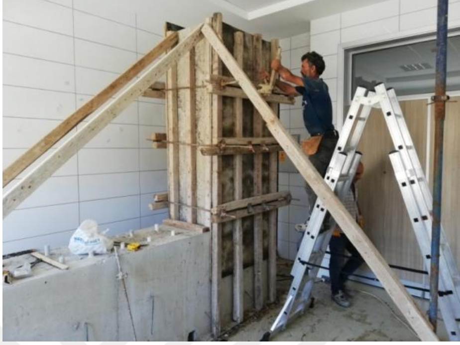
Şekil 3.9. Güçlü kolonun kalıp montajı
