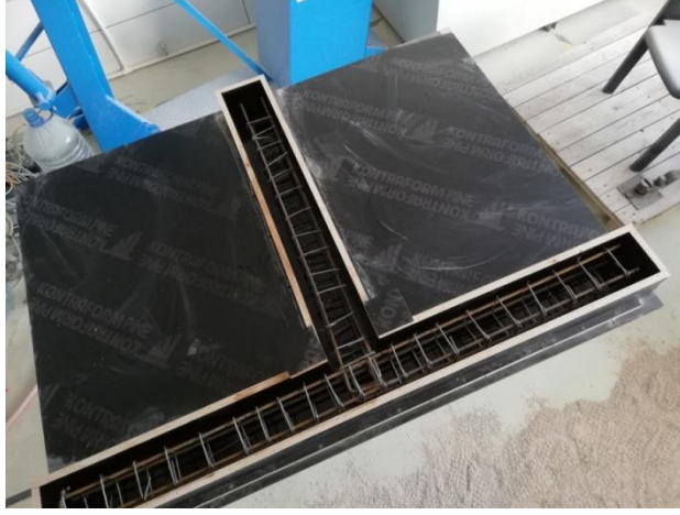
Şekil 3.19. Donatının yağlanan kalıba yerleştirilmesi
