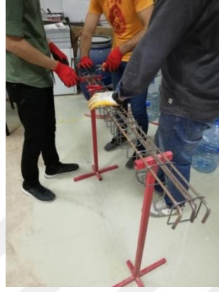
Şekil 3.17. Etriyelerin boyuna donatılara bağlama teli ile montajı
