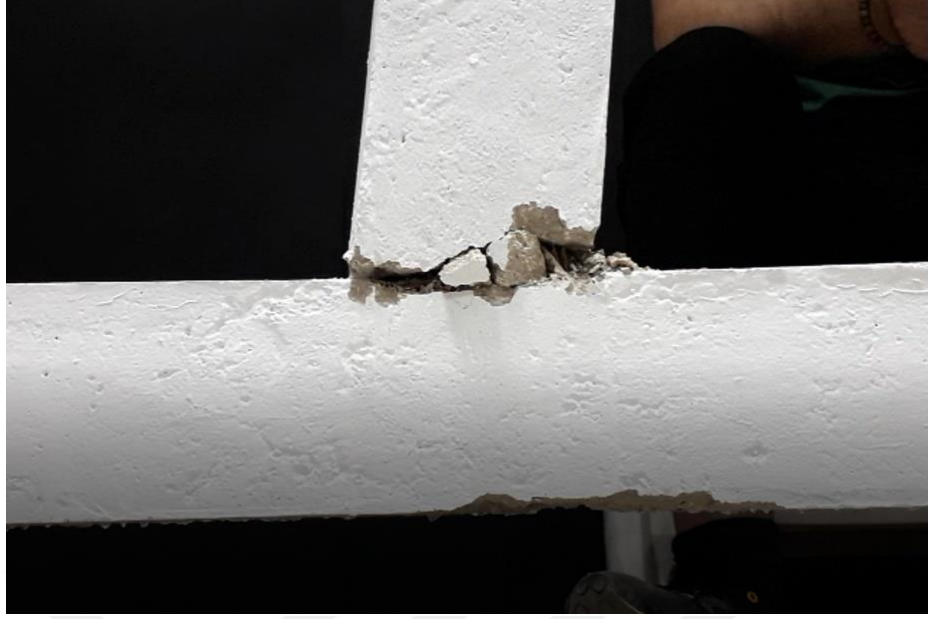
Şekil 4.27. 3 nolu deneyde +90 milimetrelik deplasman sonucunda birleşim bölgesinin hasar durumu
