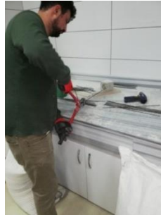
Şekil 3.16. Donatıların demir makası ile kesilmesi
