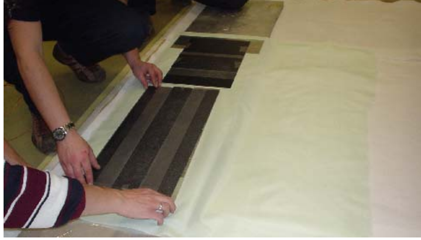
Şekil 5.32 Film yapıştırıcılar yapıştırıldıktan sonra vakum işleminin yapılması.
