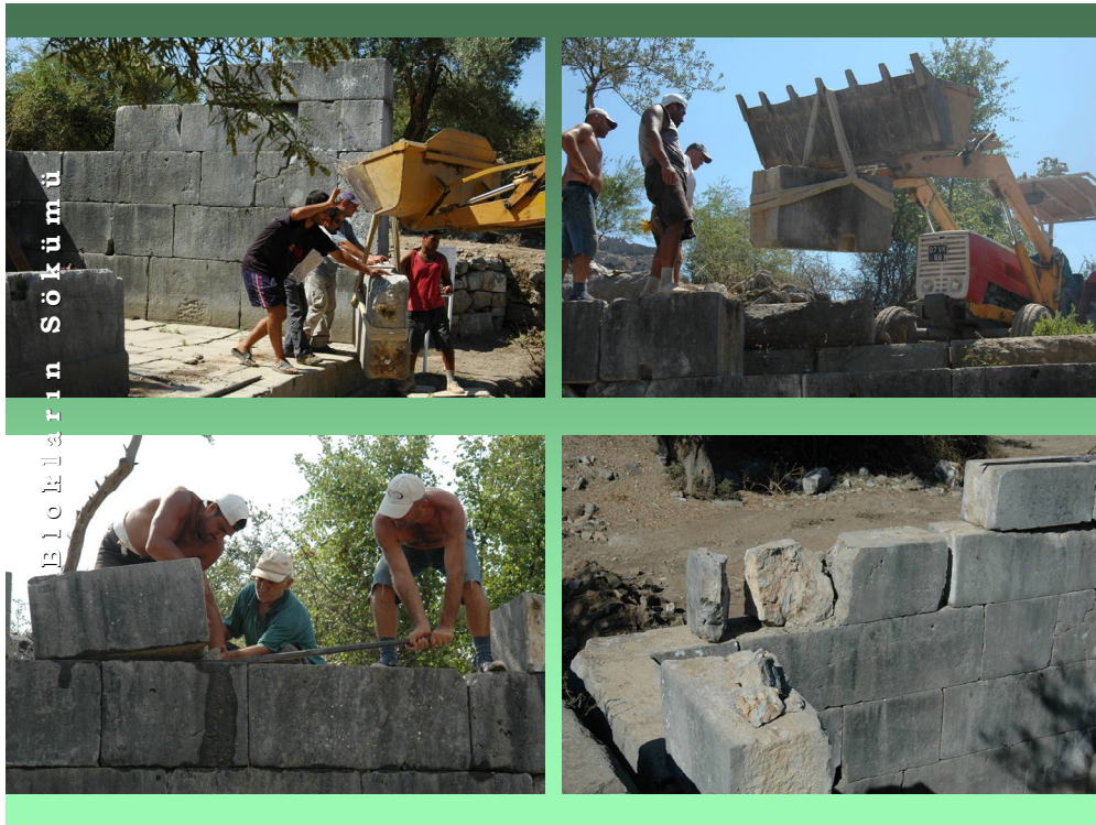
Şekil 6.8: Blokların Sökümü
