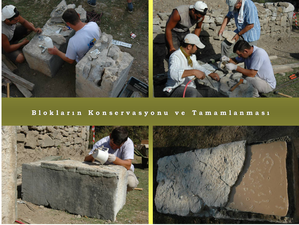
Şekil 6.9: Blokların Konservasyonu ve Tamamlanması
