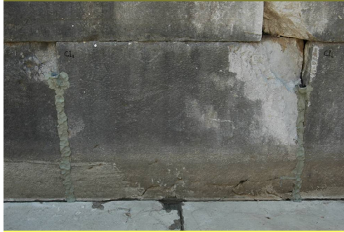
Şekil 6.11: Haznenin İzolasyonu
