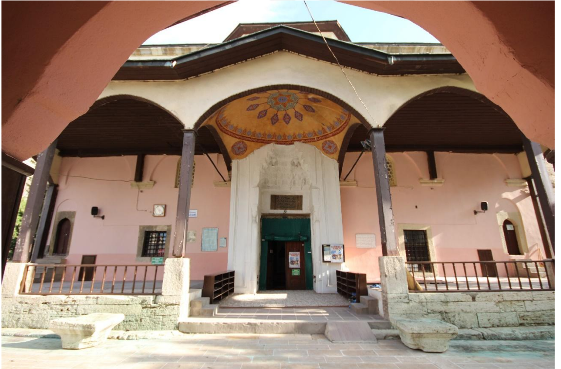
Fotoğraf 39: Gümüşlü Camii'nin Kuzey Cephesinden Görünümü
