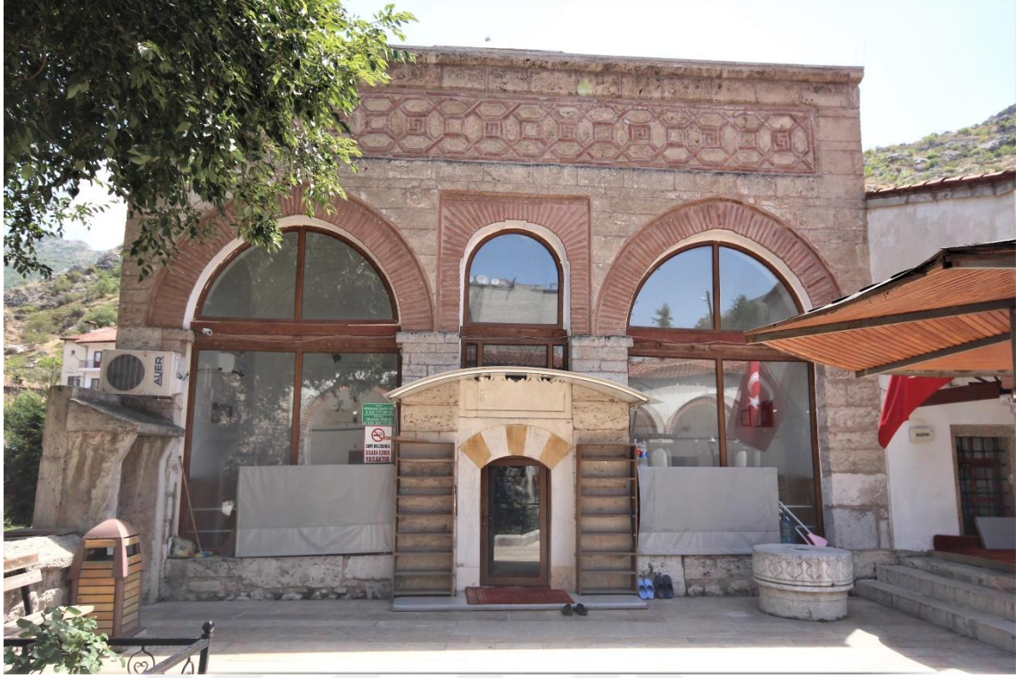
Fotoğraf 202: Şamlar Camii Kuzey Cephesi
