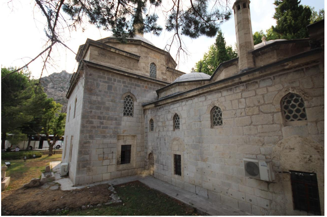
Fotoğraf 150: Mehmed Paşa Camii Doğu Cephesi
