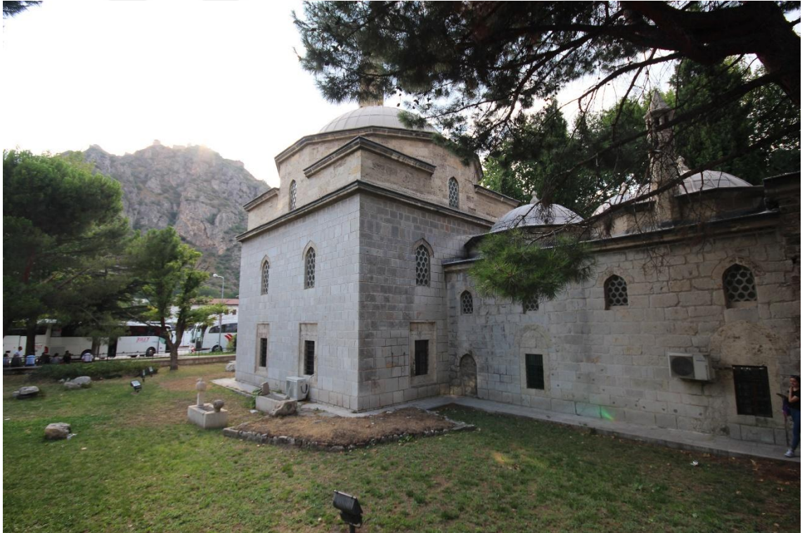
Fotoğraf 151: Mehmed Paşa Camii Doğu Cephesi
