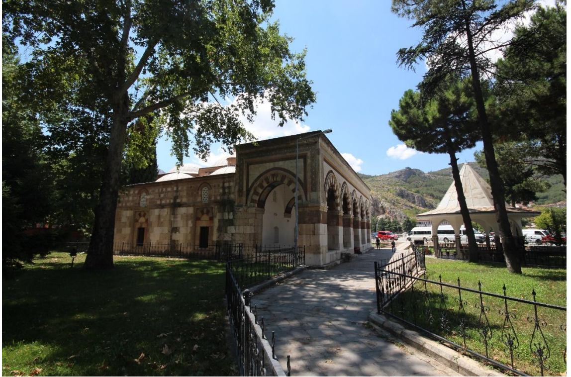
Fotoğraf 105: Bayezid Paşa İmaretî Doğu Cephesi ve Şadırvanı
