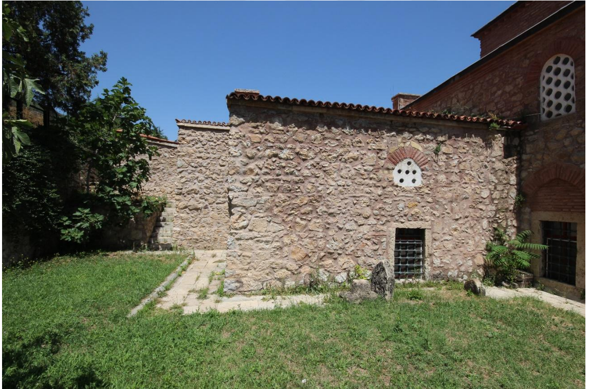
Fotoğraf 197: Şamlar Camii Batısındaki Medrese Odaları
