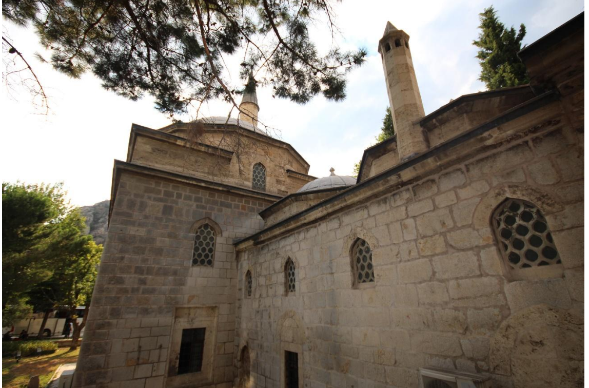
Fotoğraf 149: Mehmed Paşa Camii Doğu Cephesi
