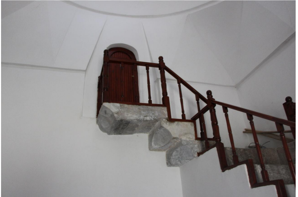
Fotoğraf 115: Bayezid Pařa İmaretinde Merdiven Detayı
