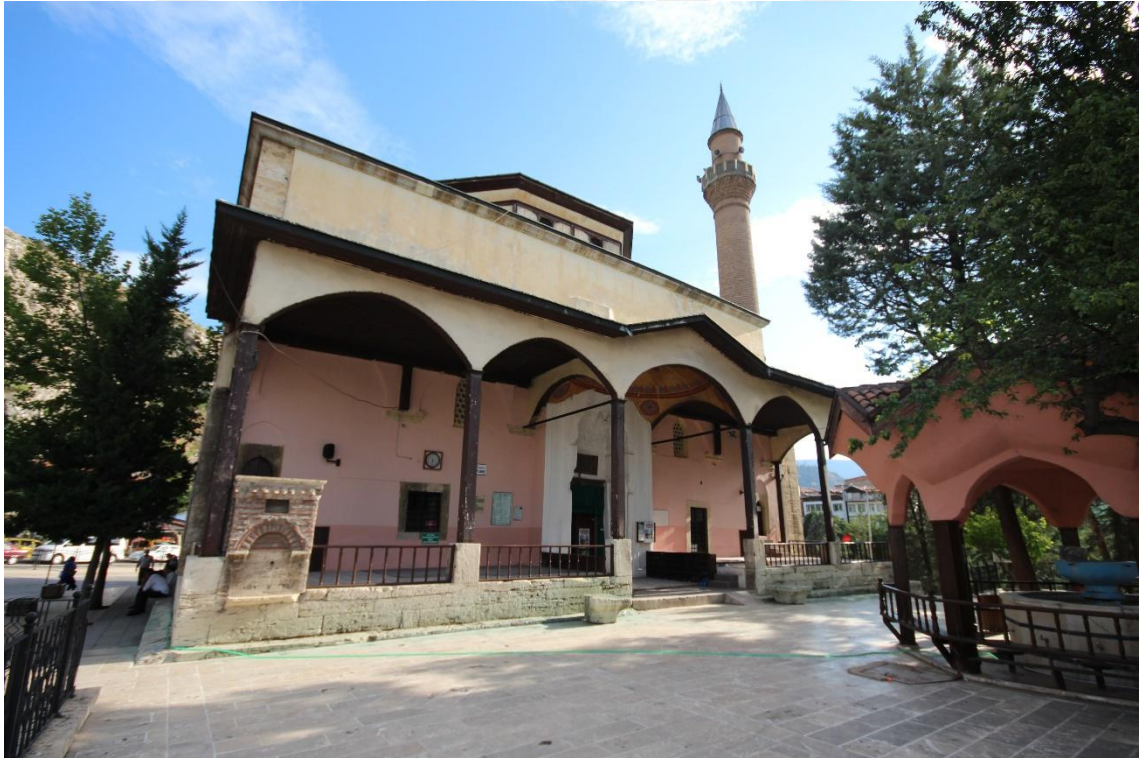
Fotoğraf 37: Gümüşlü Camii'nin Giriş Cephesinden Görünümü
