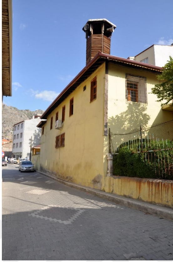
Fotoğraf 226: Üçler Camii Kuzey Cephesi
