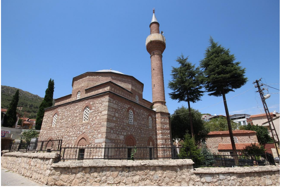
Fotoğraf 194: Şamlar Camii Güney ve Doğu Cephelerinin Görünümü
