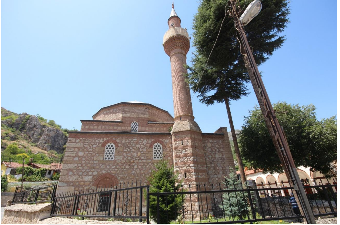
Fotoğraf 198: Şamlar Camii Doğu Cephesi
