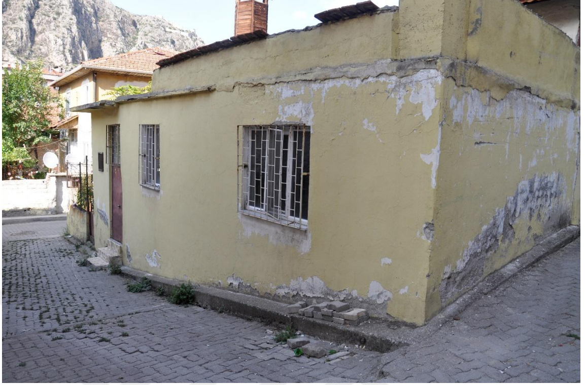
Fotoğraf 224: Üçler Camii Batı Cephesi
