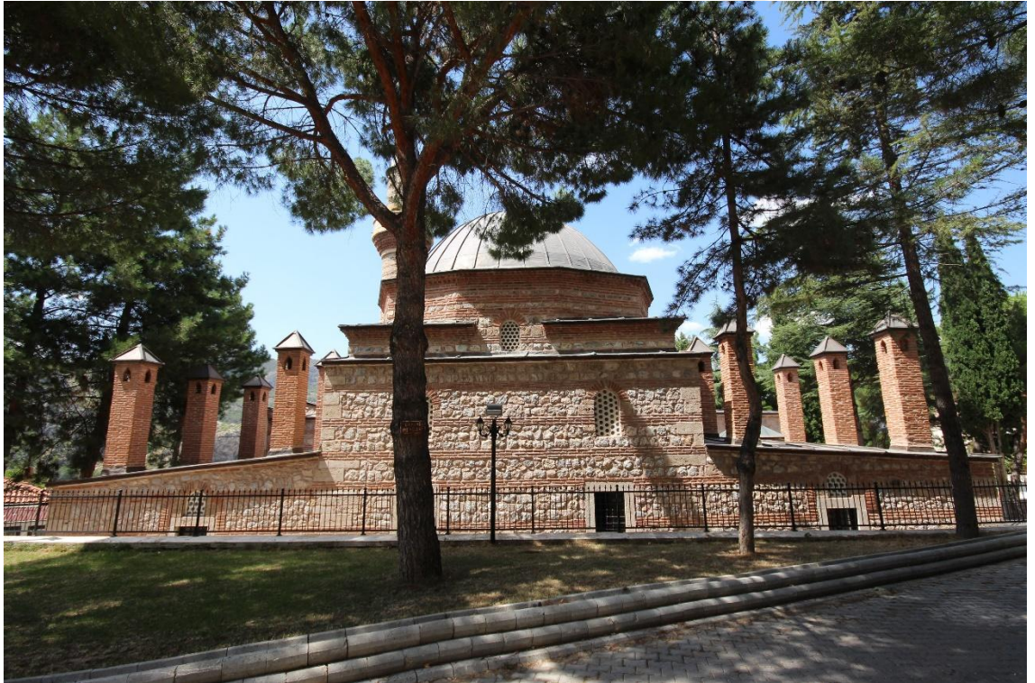
Fotoğraf 51: Çilehane Tekkesi Güney Cephesi
