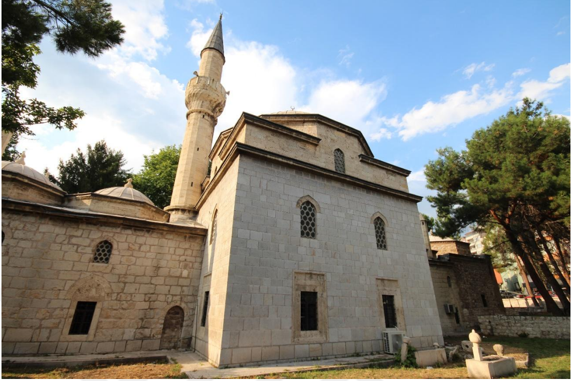
Fotoğraf 152: Mehmed Paşa Camii Doğu Cephesi
