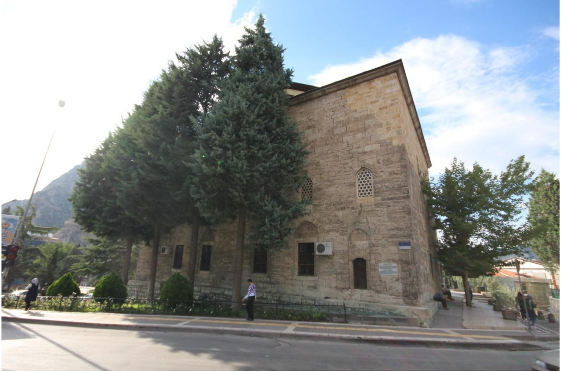
Fotoğraf 35: Gümüşlü Camii'nin Güney Cephesinden Görünümü
