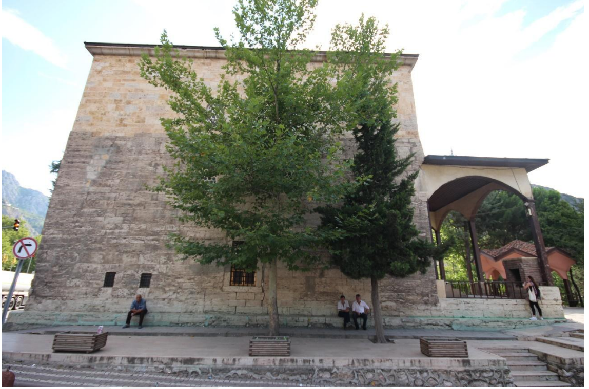
Fotoğraf 36: Gümüşlü Camii'nin Doğu Cephesinden Görünümü
