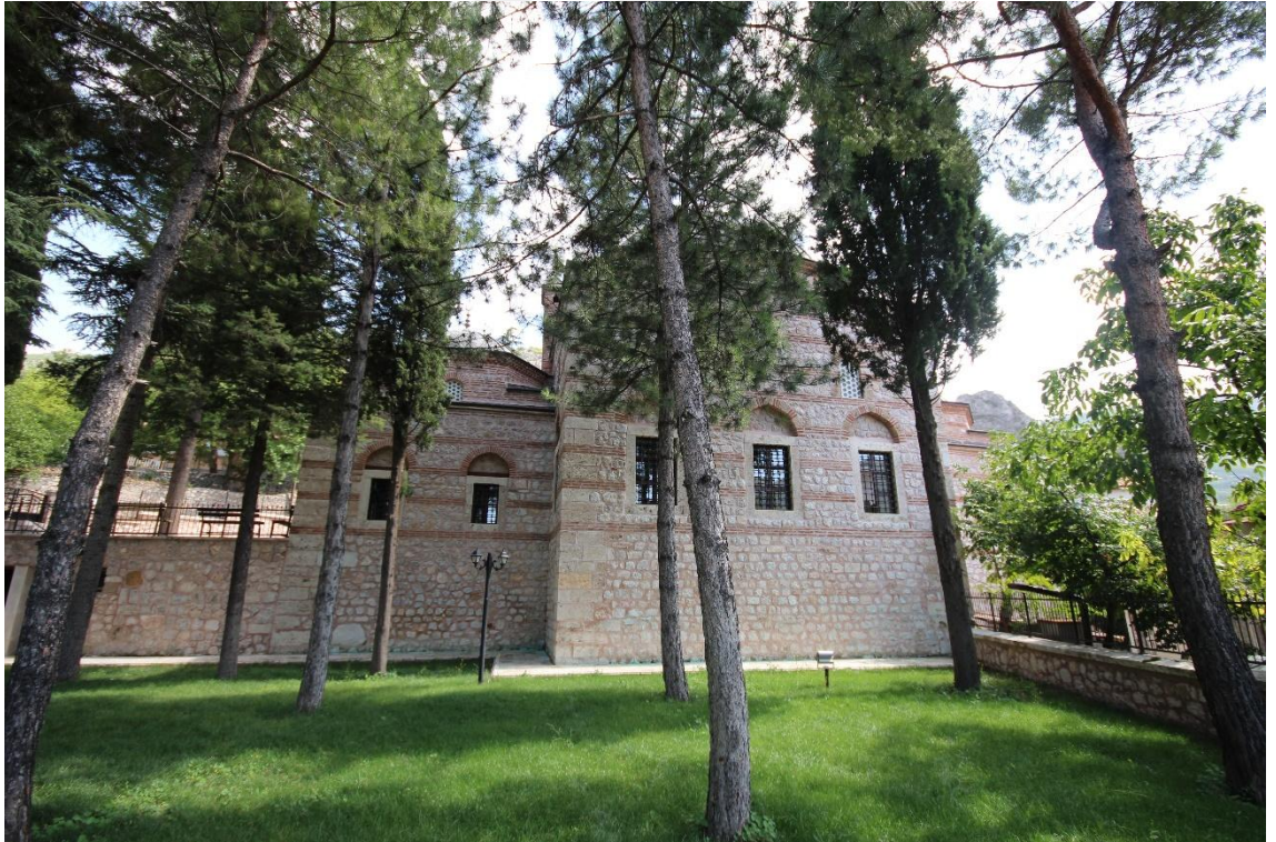
Fotoğraf 59: Çilehane Tekkesi Kuzey Cephesi
