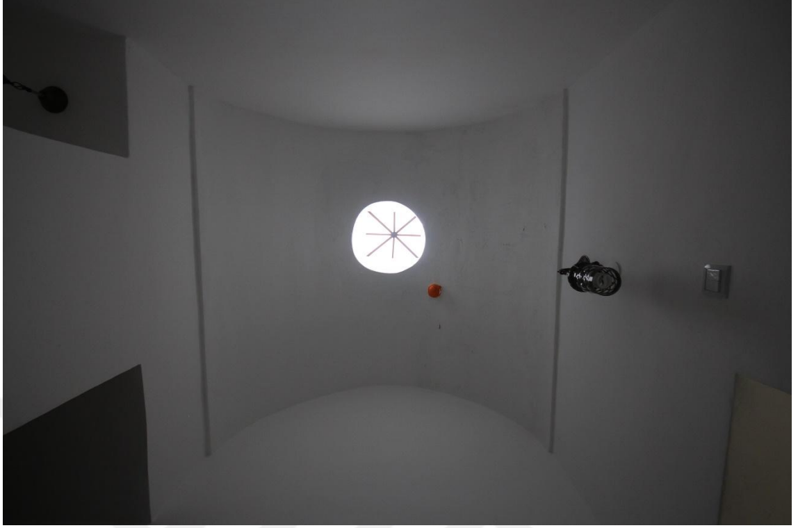
Fotoğraf 74: Çilehane Tekkesi Dehlizin Batı Tarafında Bulunan Hücrenin Aydınlık Fenerli Tonozu
