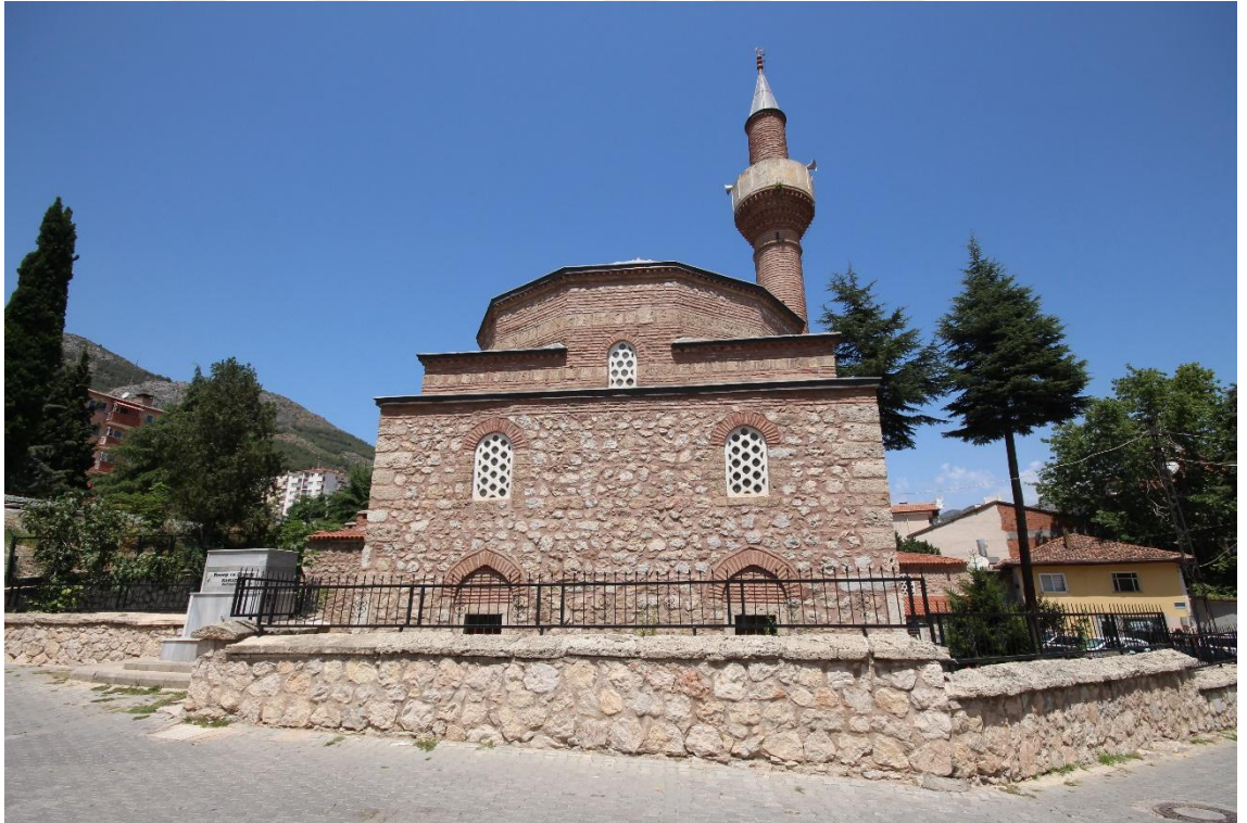
Fotoğraf 195: Şamlar Camii Güney Cephesi
