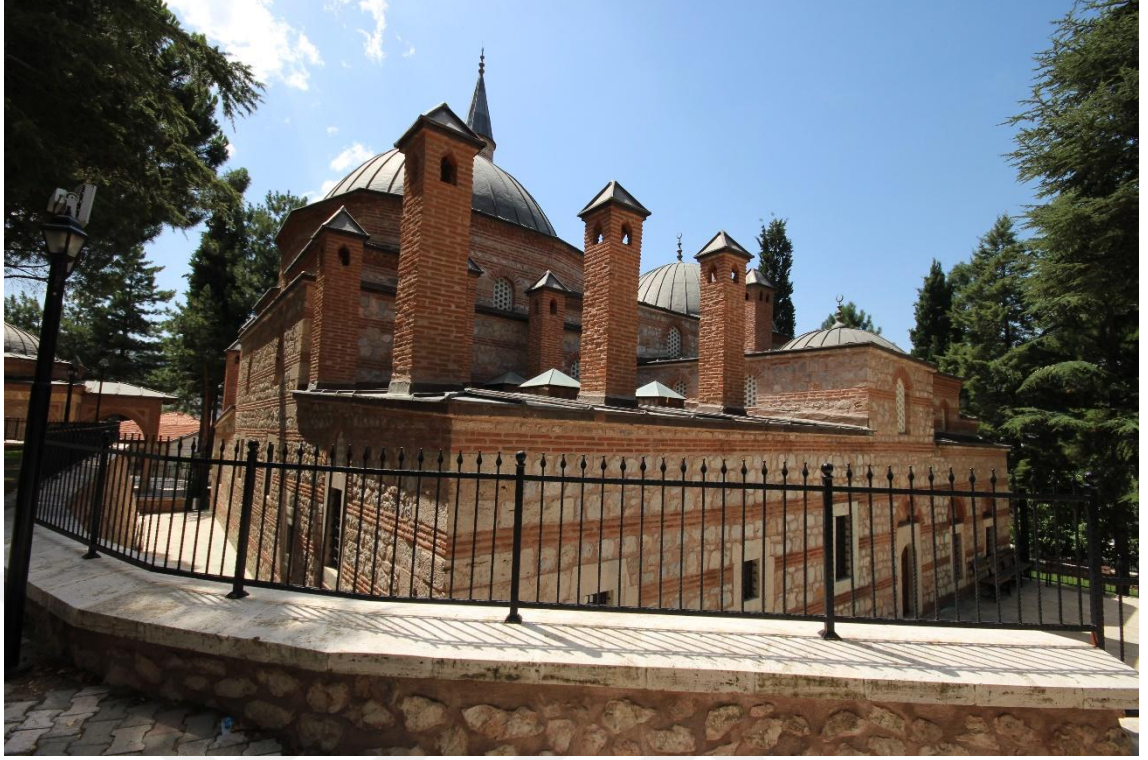
Fotoğraf 50: Çilehane Tekkesinin Güney Cephesi ve Doğu Cephelerinin Bir Görünümü
