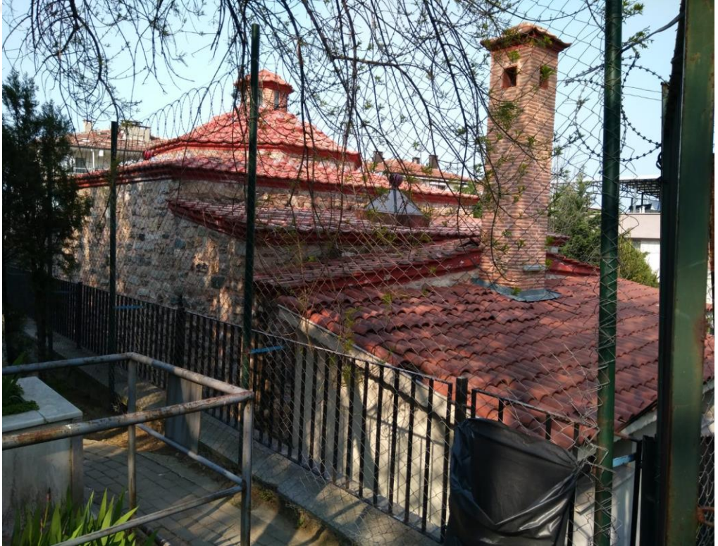
Hançerli Hamamı'nın Batı Cephesi.
