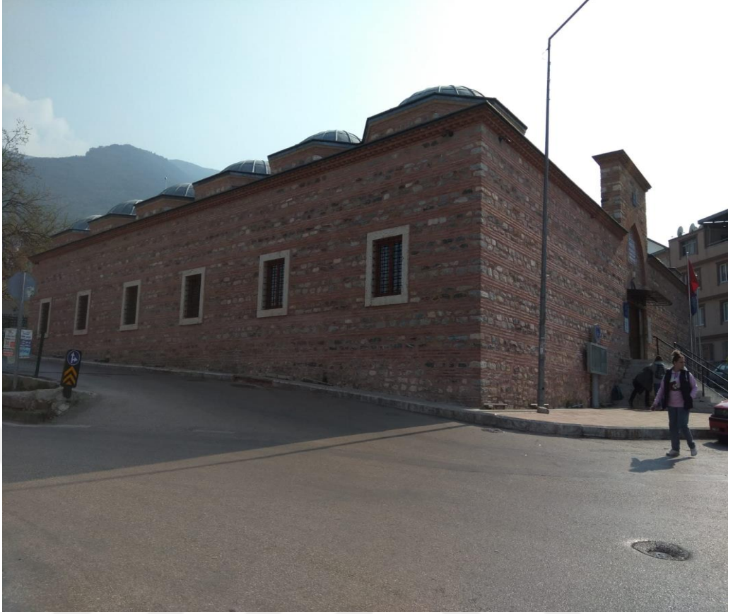
Hançerli Medresesi'nin Doğu Cephesi.
