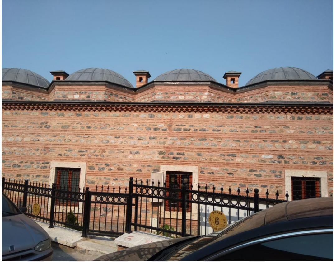
Hançerli Medresesi'nin Batı Cephesi.
