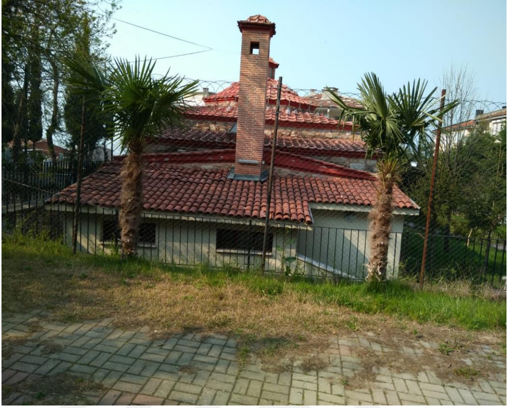
Hançerli Hamamı'nın Güney Cephesi.
