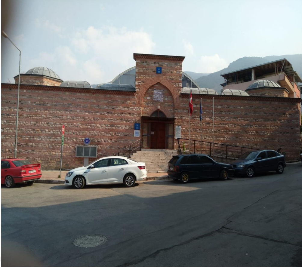
Hançerli Medresesi'nin güney cephesi ve girişi.
