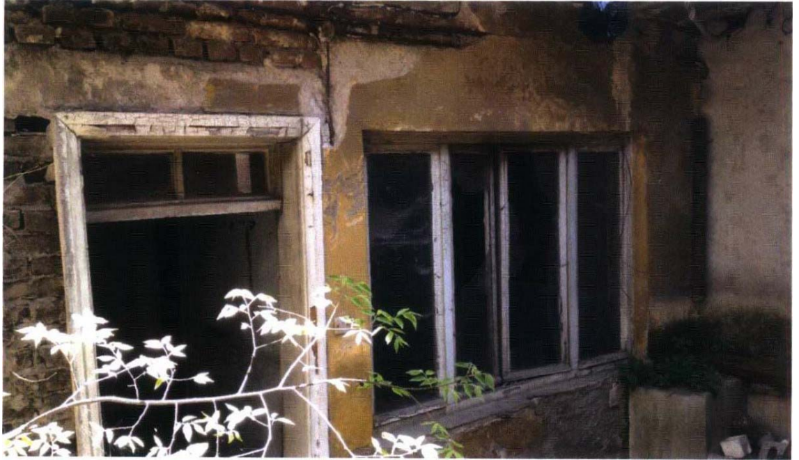
Şekil 29: Surp Asdvadzadzin Kilisesi'nin kuzeybatı köşesinde bulunan yapıların görünüşü.
