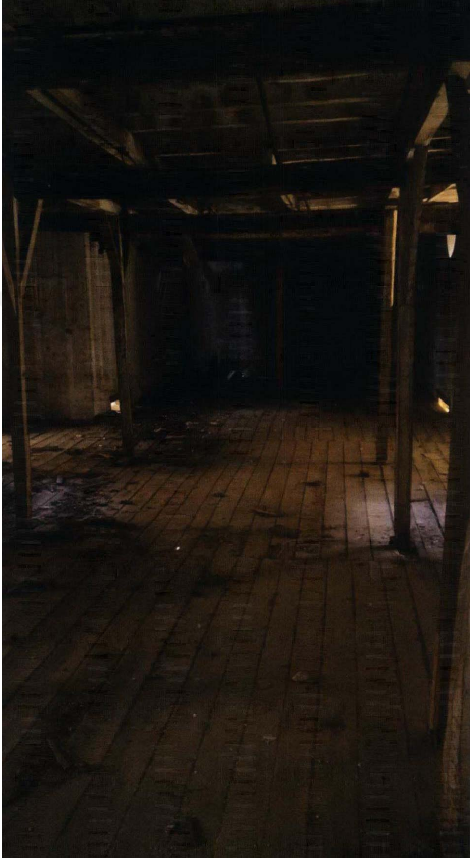
Şekil 22: Surp Asdvadzadzin Kilisesi ikinci kat döşemesi tavanı.
