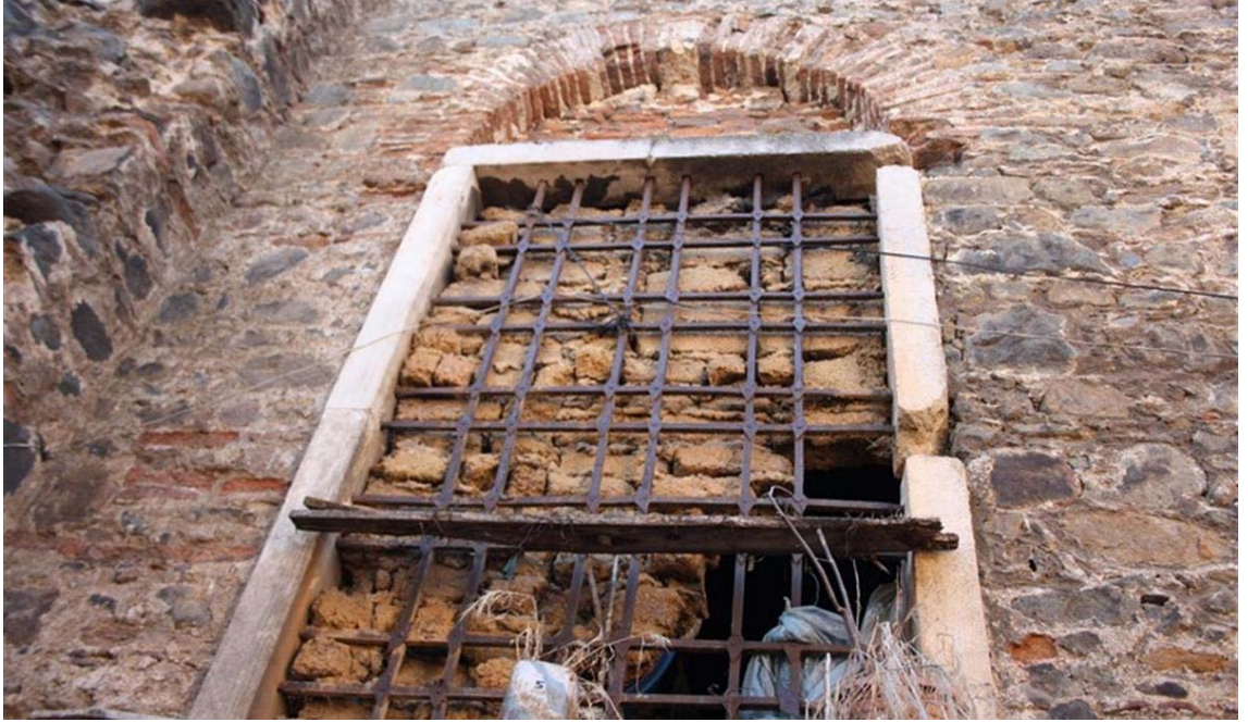
Şekil 42: Yenigürle Ermeni Kilisesi'nin kuzey duvarında kapatılan pencerenin görünüşü.
