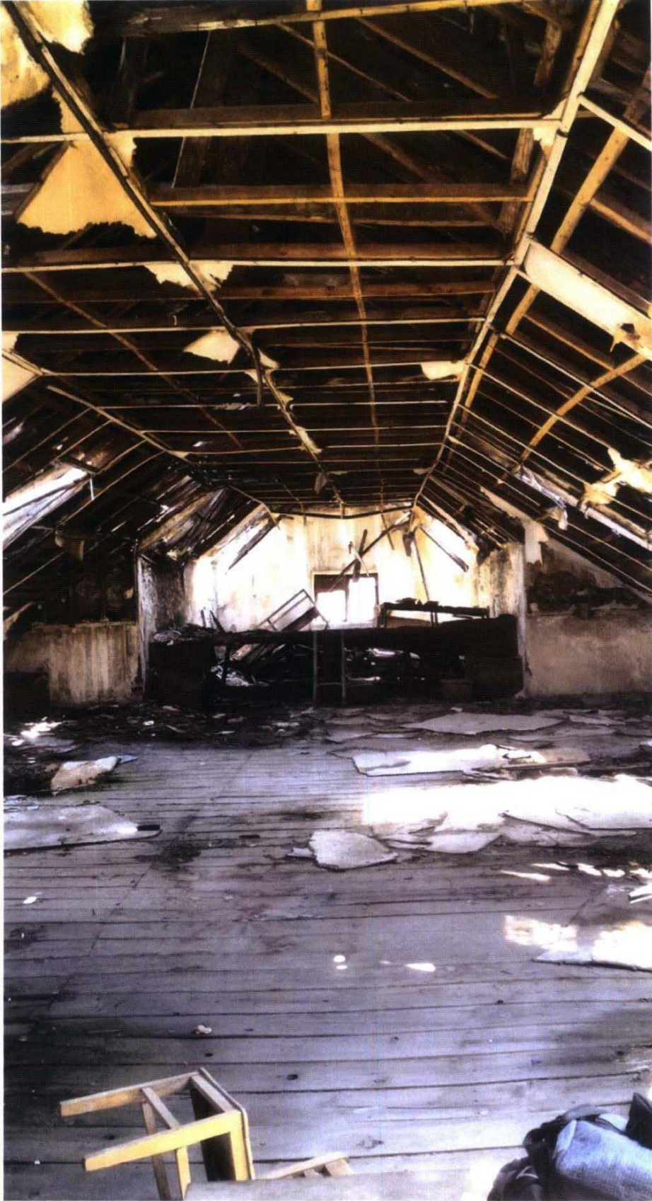
Şekil 23: Surp Asdvadzadzin Kilisesi çatının ahşap konstrüksiyonu.
