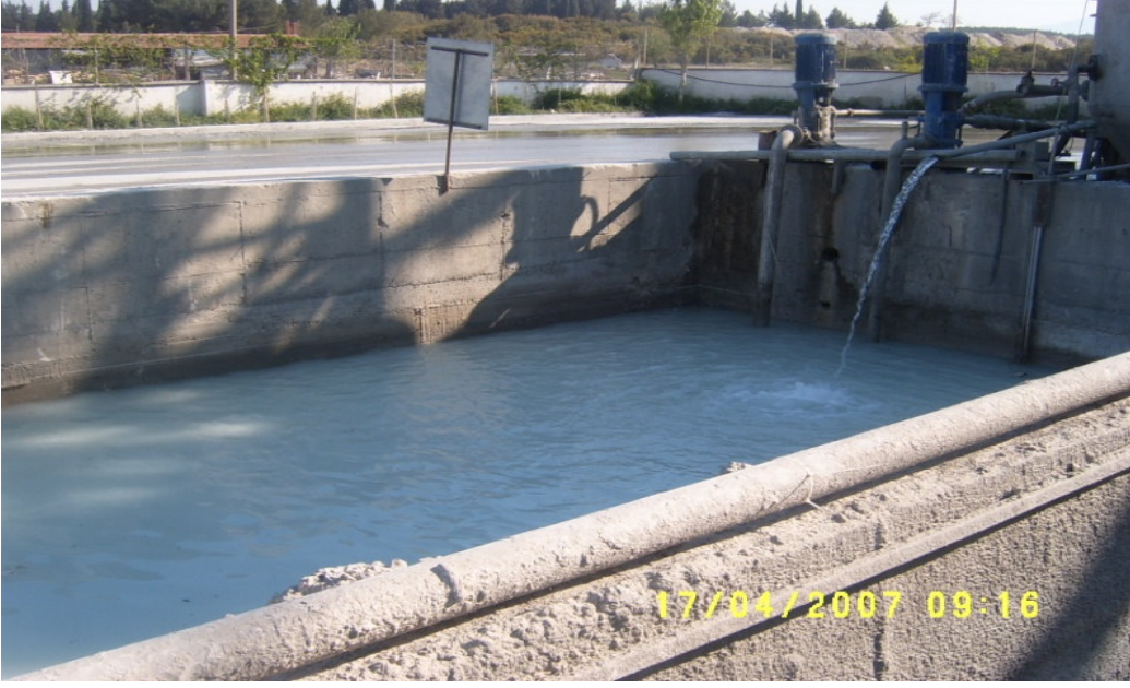
Resim 3.18 b- Geri Dönüşüm Havuzu
