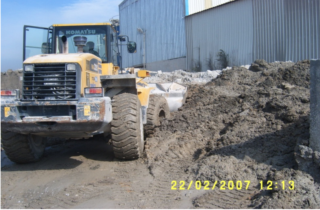
Resim 3.14 Atık Malzeme Kurutma Yeri 2
