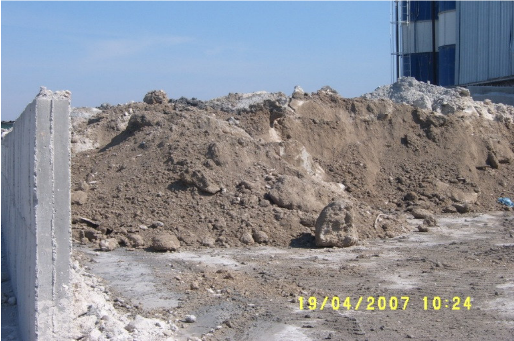
Resim 3.15 Atık Malzeme Kurutma Yeri 3
