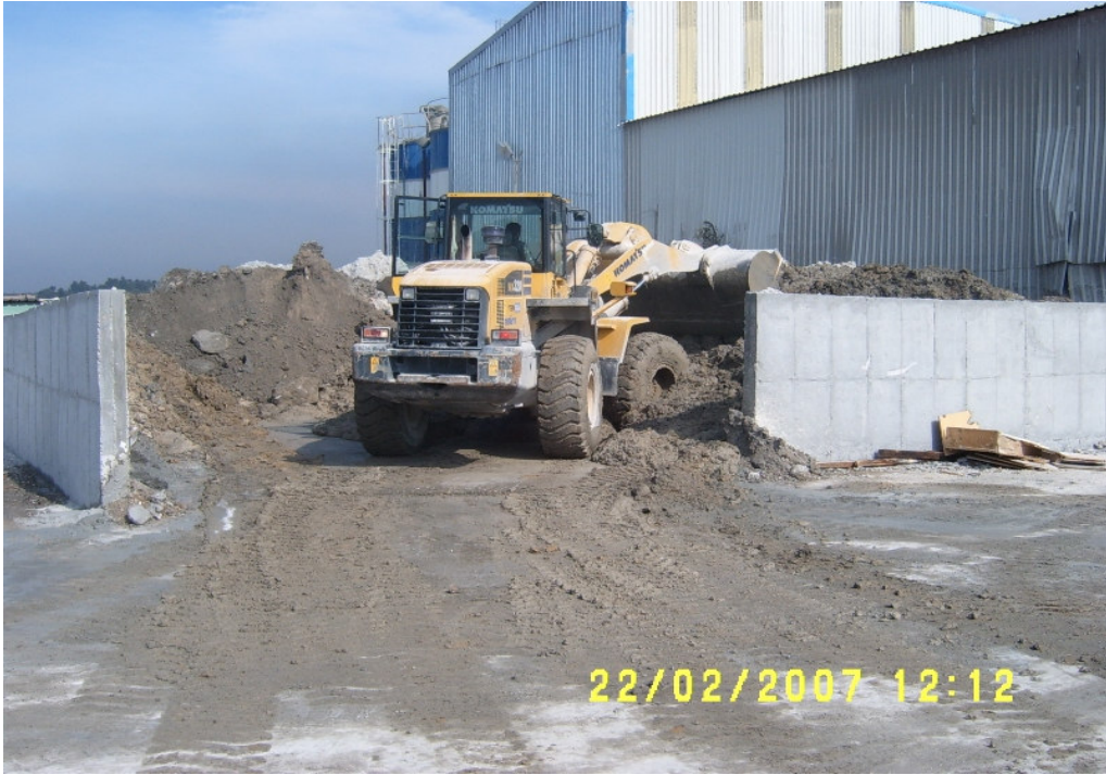
Resim 3.13 Atık Malzeme Kurutma Yeri 1
