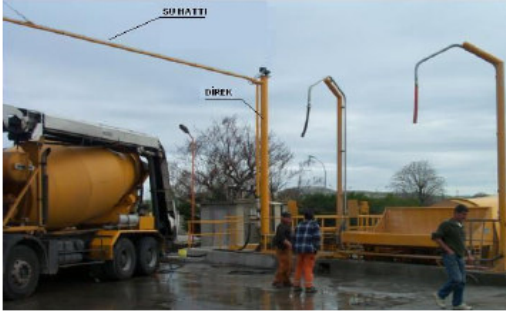
Resim 3.9 Santrale Giden Atık Su Boru Hattı
