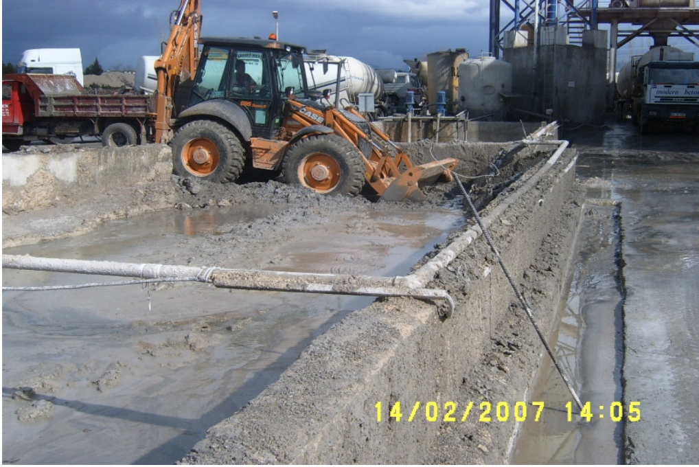
Resim 3.10 Atık Malzeme Yükleme ve Taşıma 1
