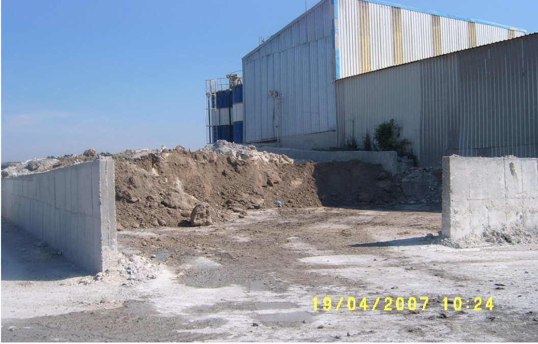
Resim 3.16 Atık Malzeme Kurutma Yeri 4
