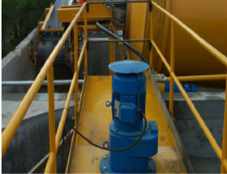
Resim 3.4 Atık Su Havuzu Ajitatörü Motor ve Redüktör
