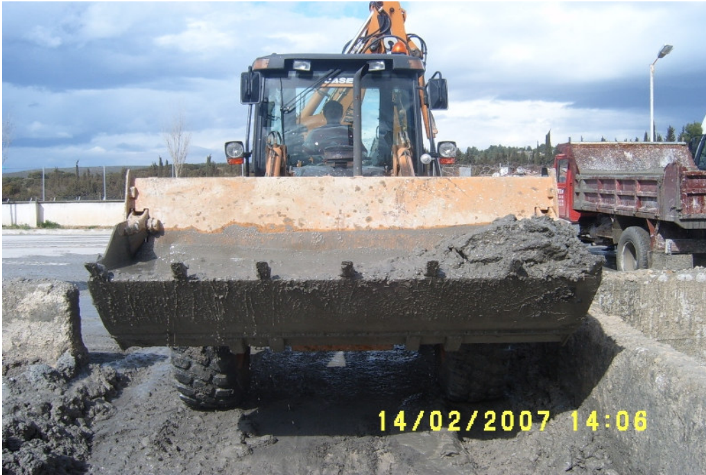
Resim 3.11 Atık Malzeme Yükleme ve Taşıma 2
