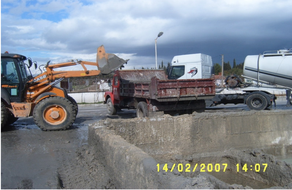
Resim 3.12 Atık Malzeme Yükleme ve Taşıma 3
