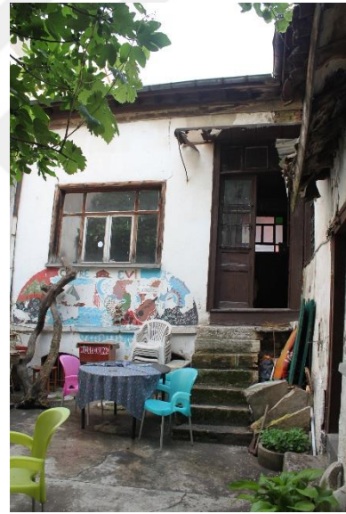
Şekil 273: K-29 Yapının Arka Bahçesi
