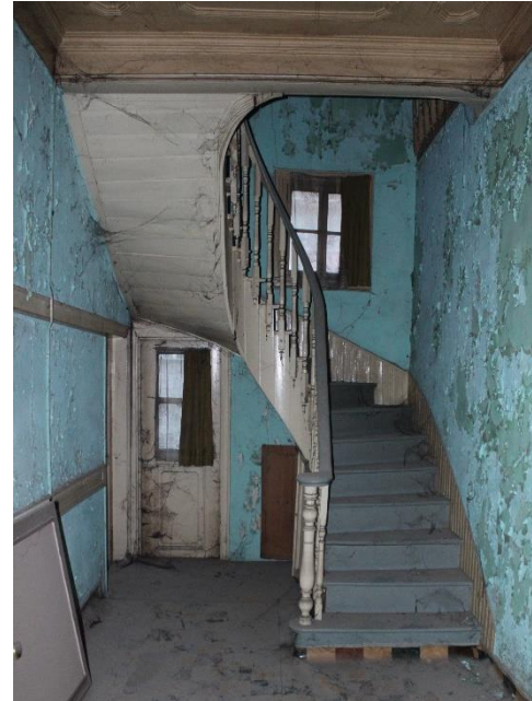
Şekil 105: Kaleiçi Evlerinden Ahşap Merdiven Örneği
