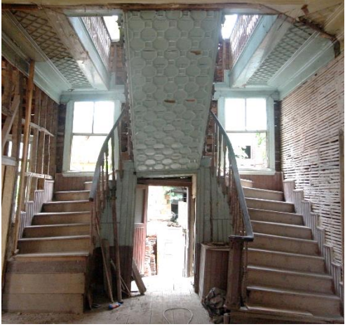
Şekil 94: Kaleiçi Evlerinden Ahşap Merdiven Örneği
