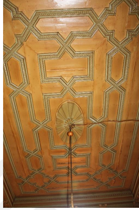
Şekil 54: Kaleiçi Evlerinden Geometrik Desenli Ahşap Çıtalı Tavan Örneği
