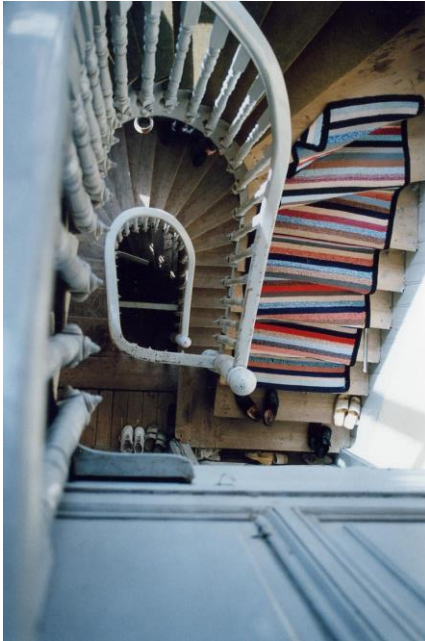
Şekil 100: Kaleiçi Evlerinden Ahşap Merdiven Örneği
