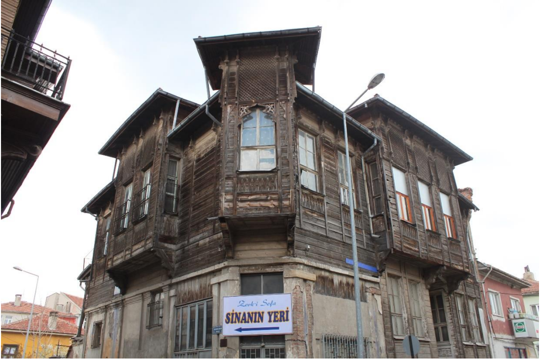
Şekil 8: Kaleiçi Evlerinden Cephe Örneği
