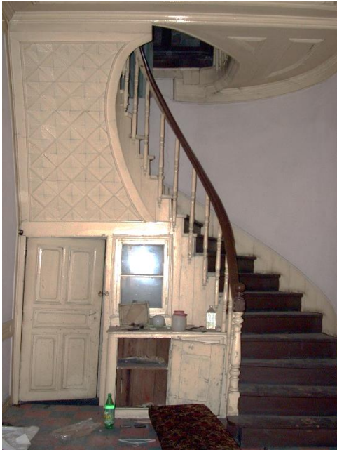
Şekil 104: Kaleiçi Evlerinden Ahşap Merdiven Örneği
