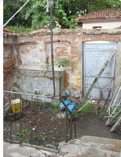
Şekil 279: K-30-31 Yapının Arka Bahçesi
