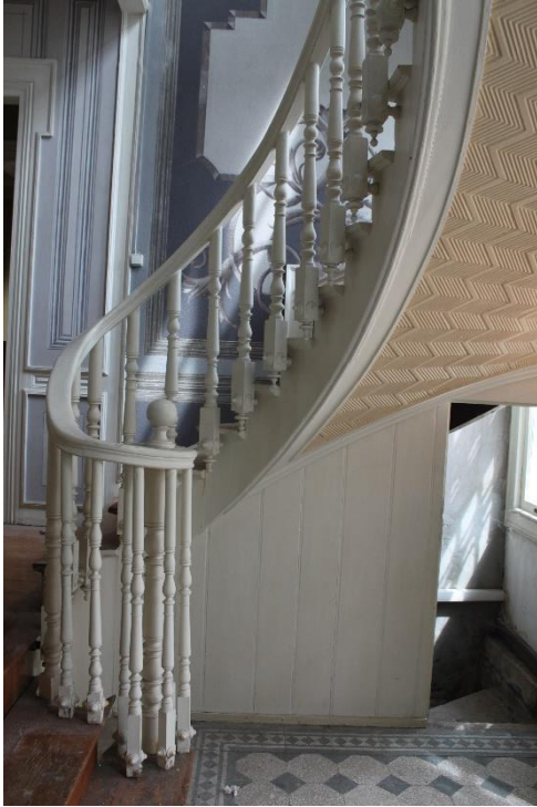
Şekil 96: Kaleiçi Evlerinden Ahşap Merdiven Örneği
