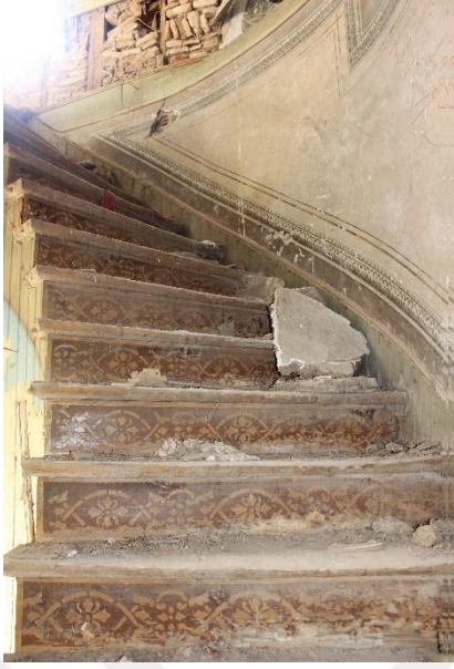
Şekil 98: Kaleiçi Evlerinden Ahşap Merdiven Örneği
