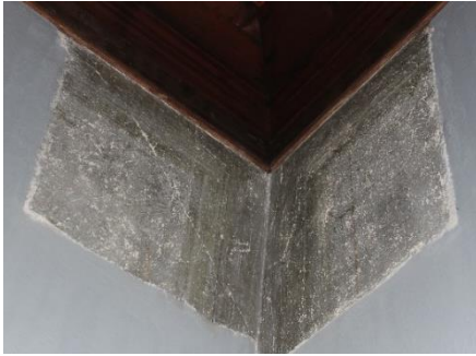
Şekil 215: K-16 Giriş Kat Odalardaki Kalem işi Süslemelerden Detaylar
