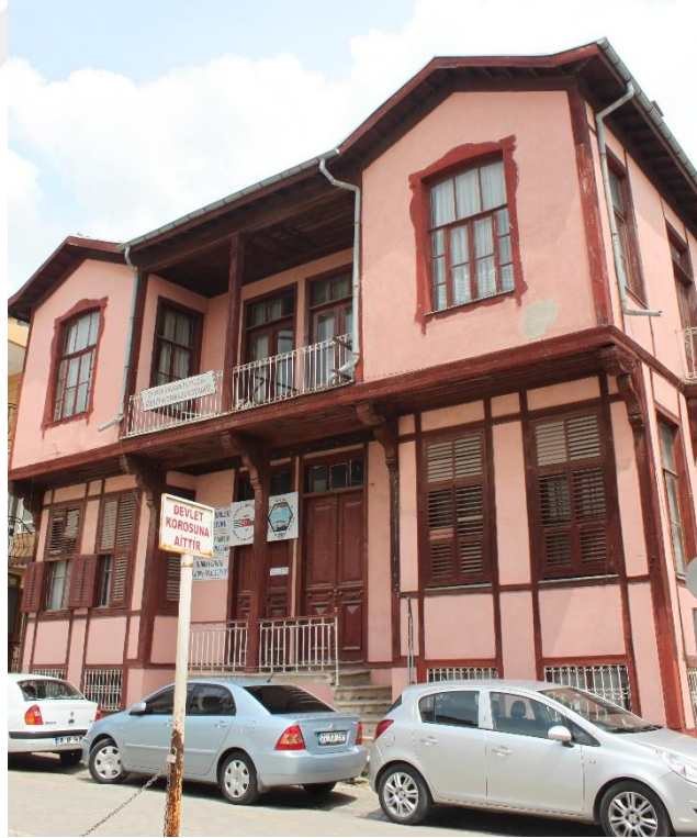
Şekil 10: Kaleiçi Evlerinden Cephe Örneği
