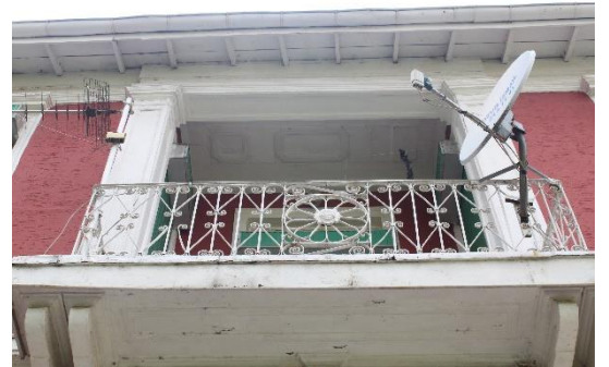
Şekil 263: K-27 Dış Cephe Balkondan Görünüm
