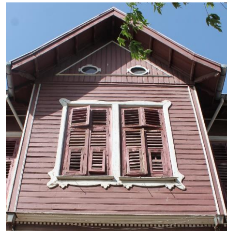
Şekil 297: K-34 Dış Cepheden Kapalı Cumba
