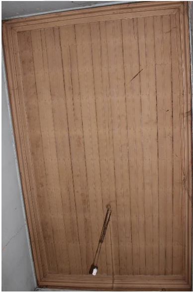
Şekil 47: Kaleiçi Evlerinden Ahşap Düz Çıtalı Tavan Örneği
