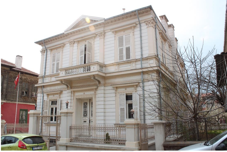
Şekil 9: Kaleiçi Evlerinden Cephe Örneği
