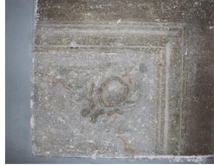
Şekil 216: K-16 Giriş Kat Odalardaki Kalem işi Süslemelerden Detaylar
