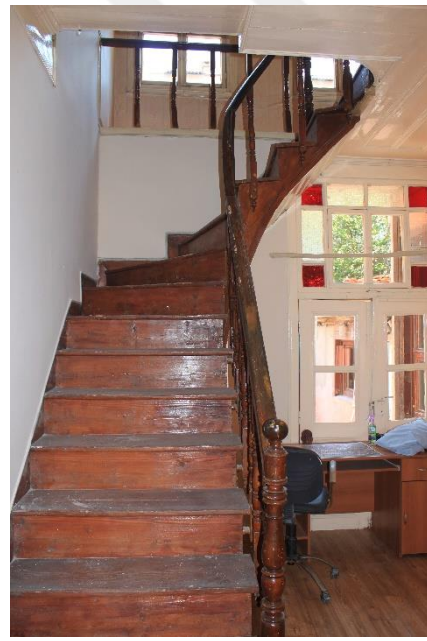
Şekil 101: Kaleiçi Evlerinden Ahşap Merdiven Örneği
