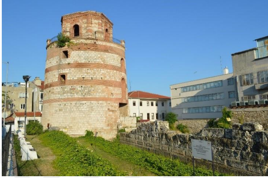
Şekil 1: Edirne Sur Duvarları Ve Makedonya Kulesi
