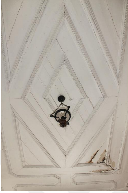
Şekil 49: Kaleiçi Evlerinden Üçgen Formunda Ahşap Çıtalı Tavan Örneği
