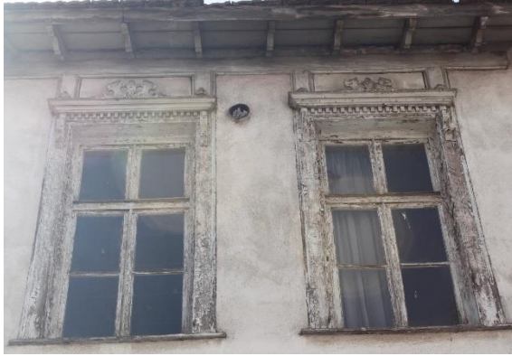
Şekil 345: K-43 Giriş Cephesi Pencere Örneği
