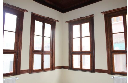
Şekil 222: K-17-18 Giriş Kat Odadan Görünüm
