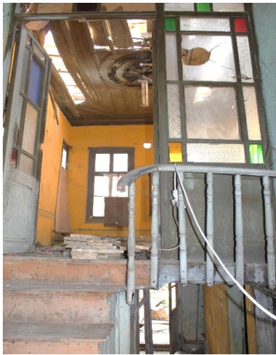
Şekil 302: K-35 Yapının Üst Kata Çıkış Merdivenleri
