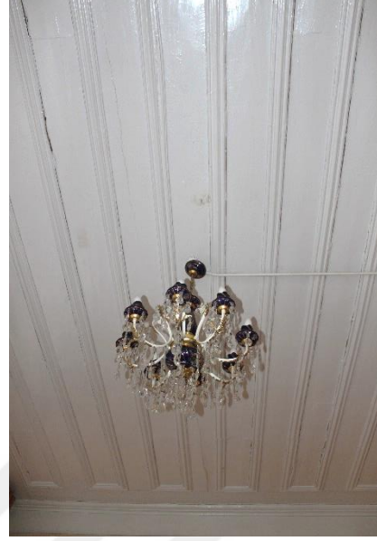
Şekil 46: Kaleiçi Evlerinden Ahşap Düz Çıtalı Tavan Örneği
