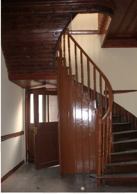
Şekil 102: Kaleiçi Evlerinden Ahşap Merdiven Örneği
