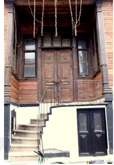
Şekil 208: K-15 Yapının Giriş Kısım
