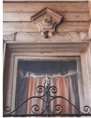
Şekil 359: K-45 Kapı Girişi Pencere Ör.
