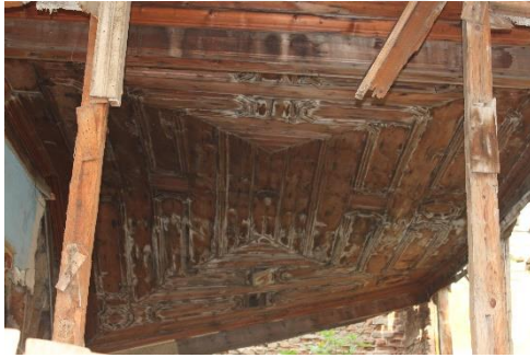
Şekil 242: K-24 Giriş Kat Ahşap Tavandan Görünüm
