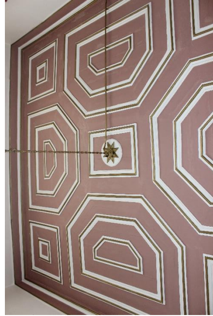
Şekil 56: Kaleiçi Evlerinden Geometrik Desenli Ahşap Çıtalı Tavan Örneği
