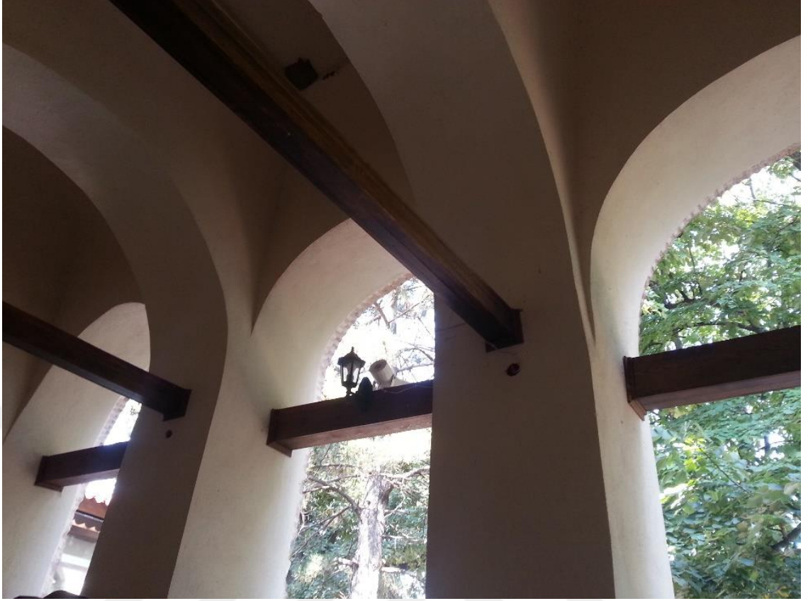
Fotoğraf 23: Baba Sultan Camii eski cami son cemaat yeri revak kemer ve gergileri
