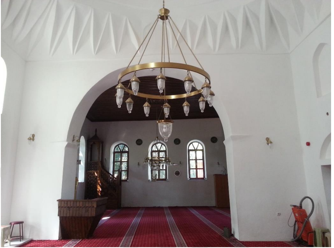
Fotoğraf 29: Baba Sultan Cami eski cami batı duvarı iç cephesi
