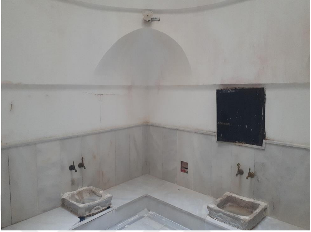
Fotoğraf 128: Baba Sultan Hamamı sıcaklık iç cephesi doğu köşesi ve sıcak su kazanı kapısı
