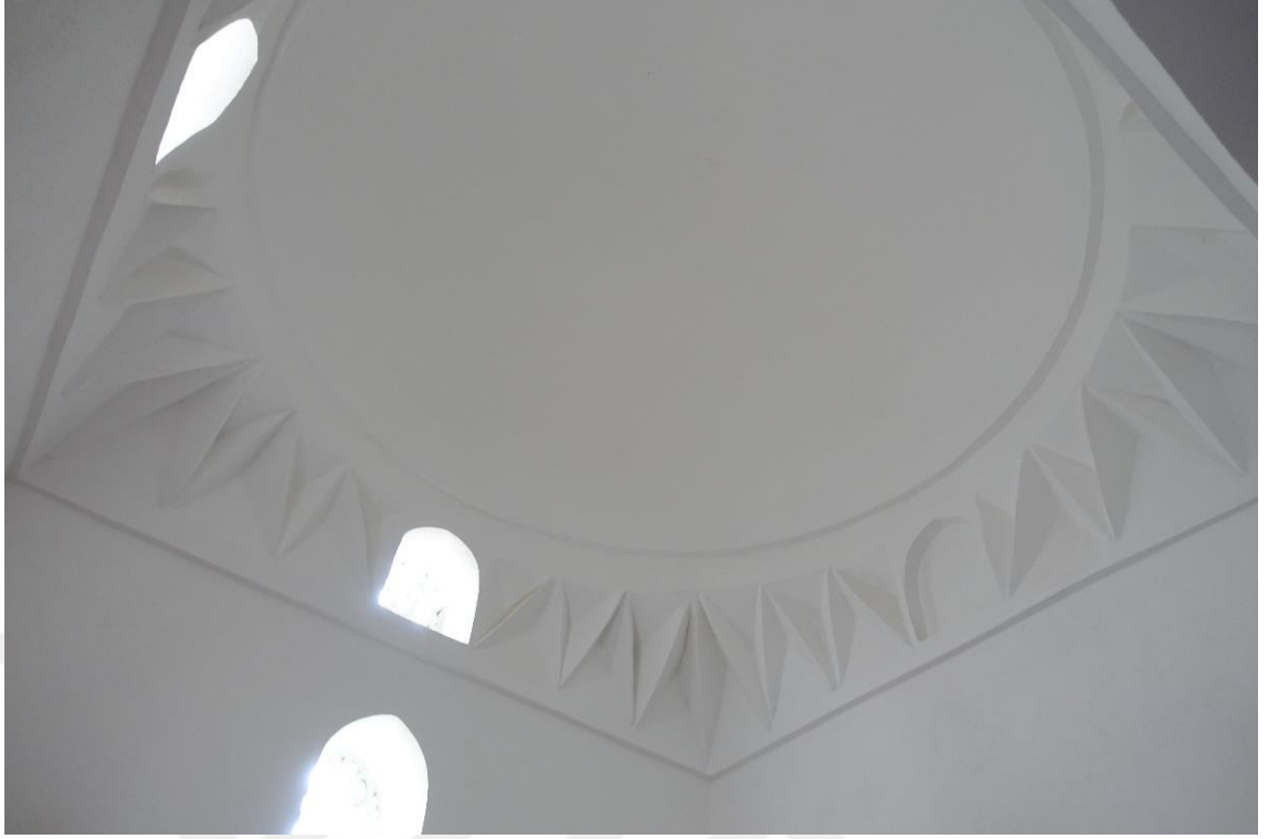
Fotoğraf 69: Baba Sultan Türbesi kubbesi ve geçiş sistemleri
