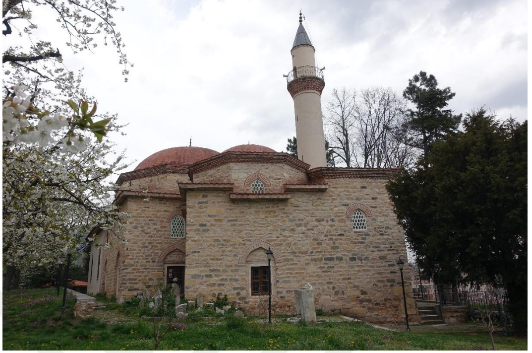
Fotoğraf 59: Baba Sultan Türbesi doğu cephesi
