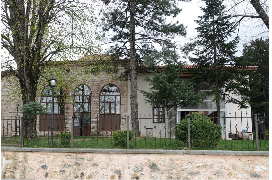
Fotoğraf 2: Baba Sultan Cami kuzey cephesi
