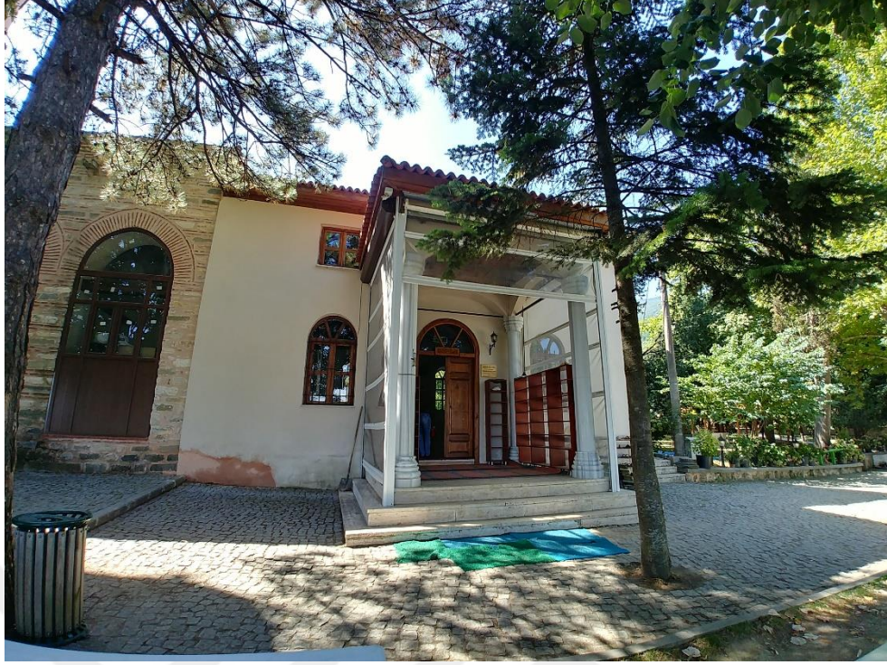
Fotoğraf 5: Baba Sultan Cami yeni cami kuzey cephesi
