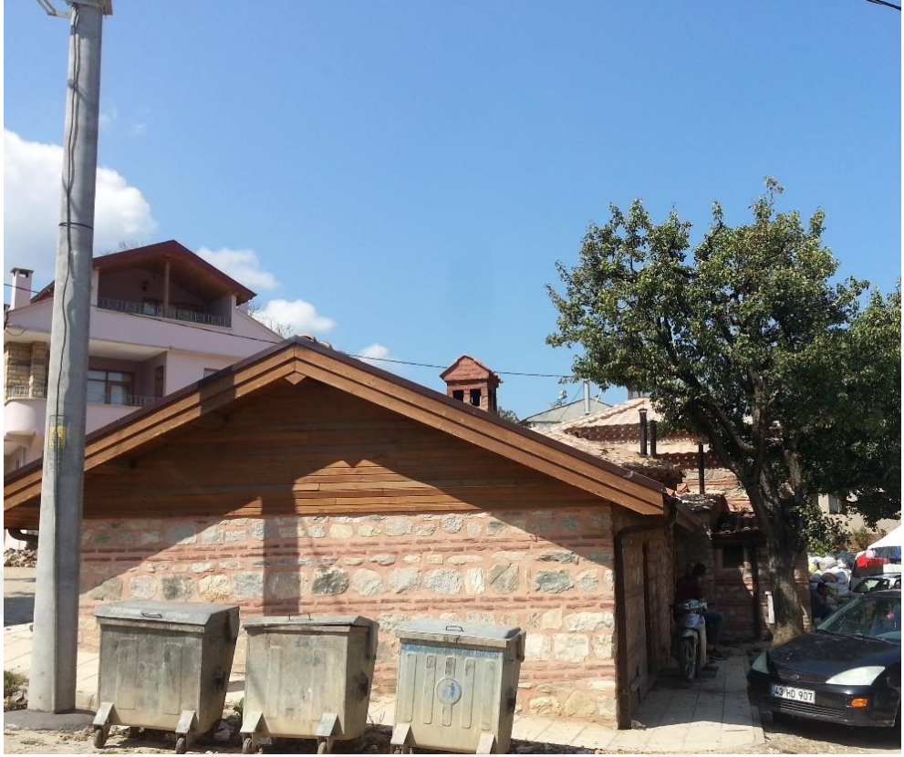
Fotoğraf 102: Baba Sultan Hamamı güneydoğu cephesi (küllhan)
