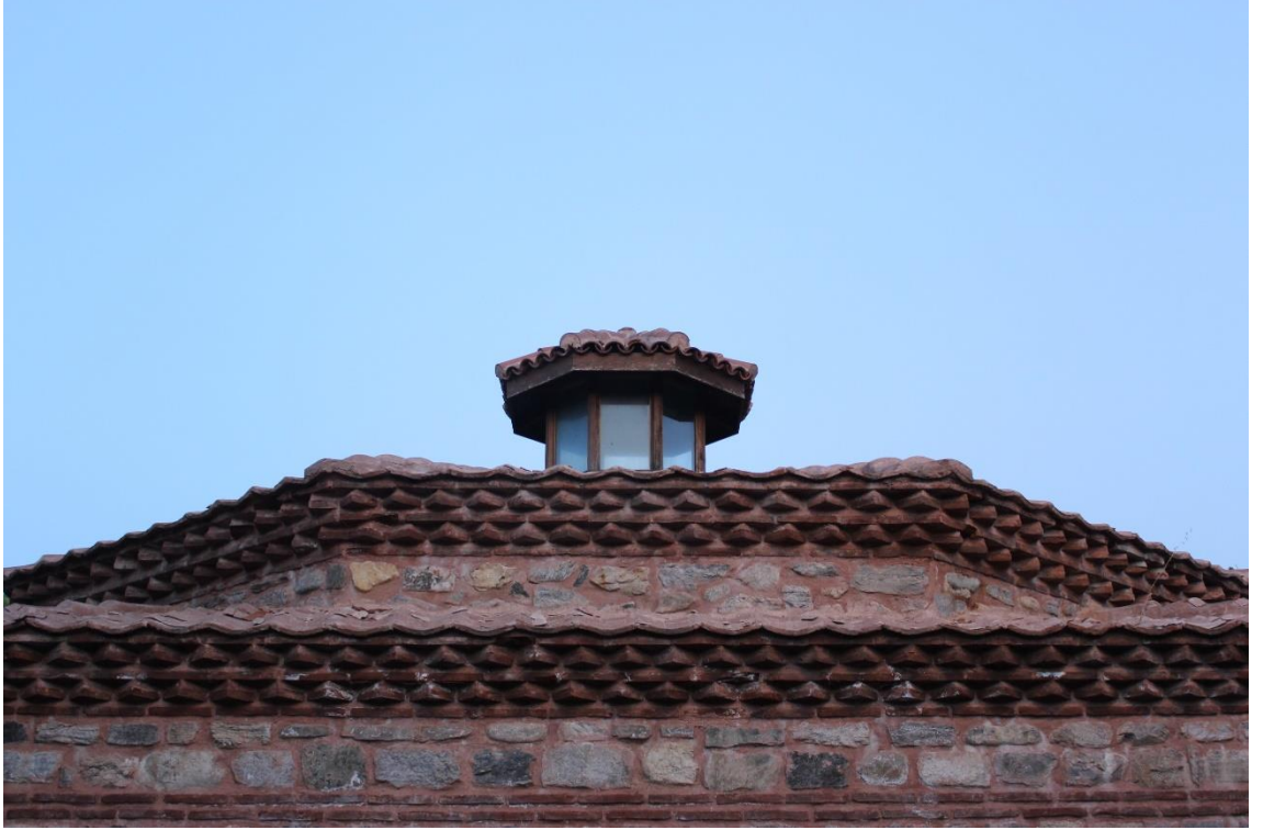
Fotoğraf 107: Baba Sultan Hamamı soğukluk kubbe saçakları ve aydınlık feneri
