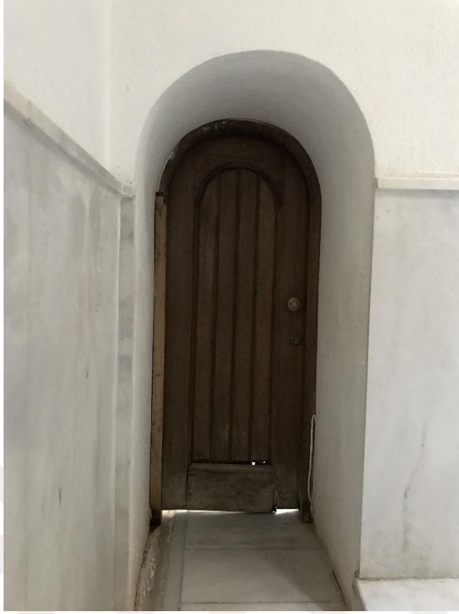
Fotoğraf 126: Baba Sultan Hamamı sıcaklığa geiř kapısı
