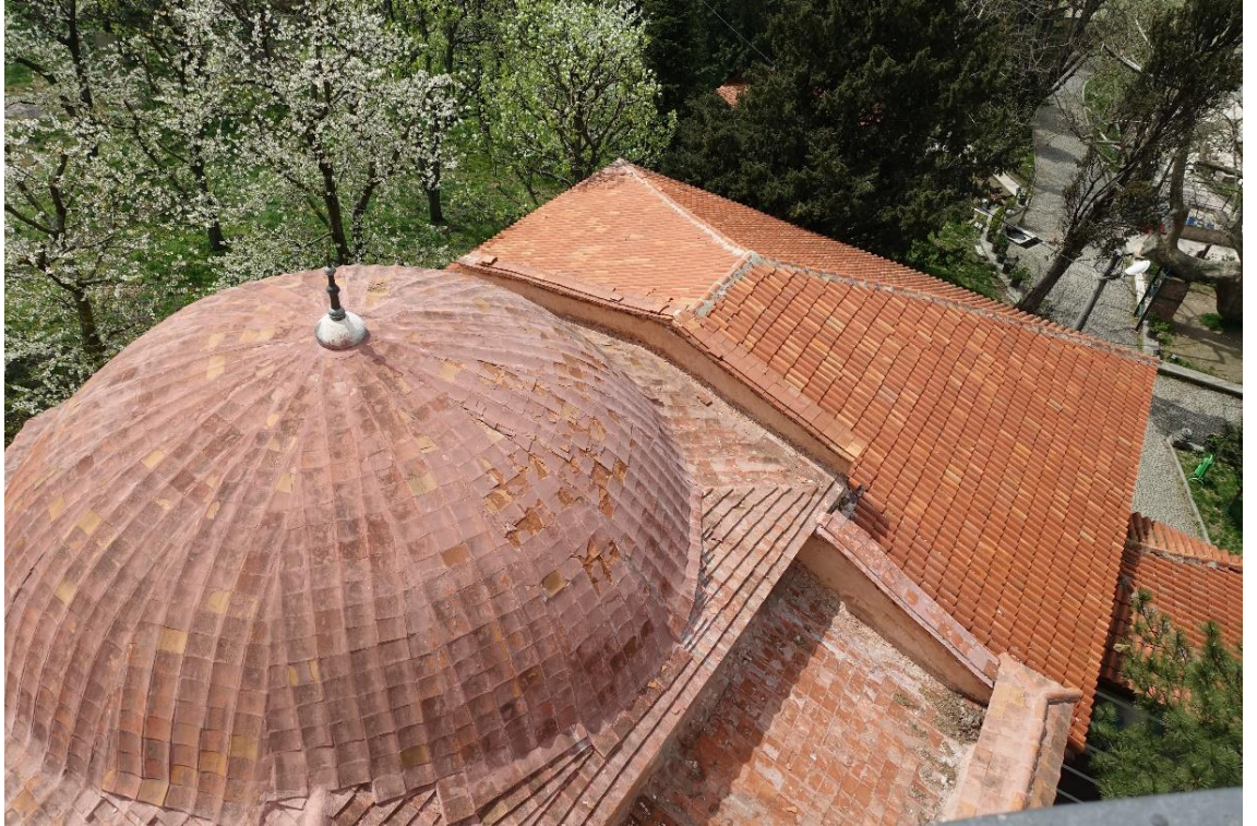
Fotoğraf 12: Baba Sultan Cami örtü sisteminin üst görünümü
