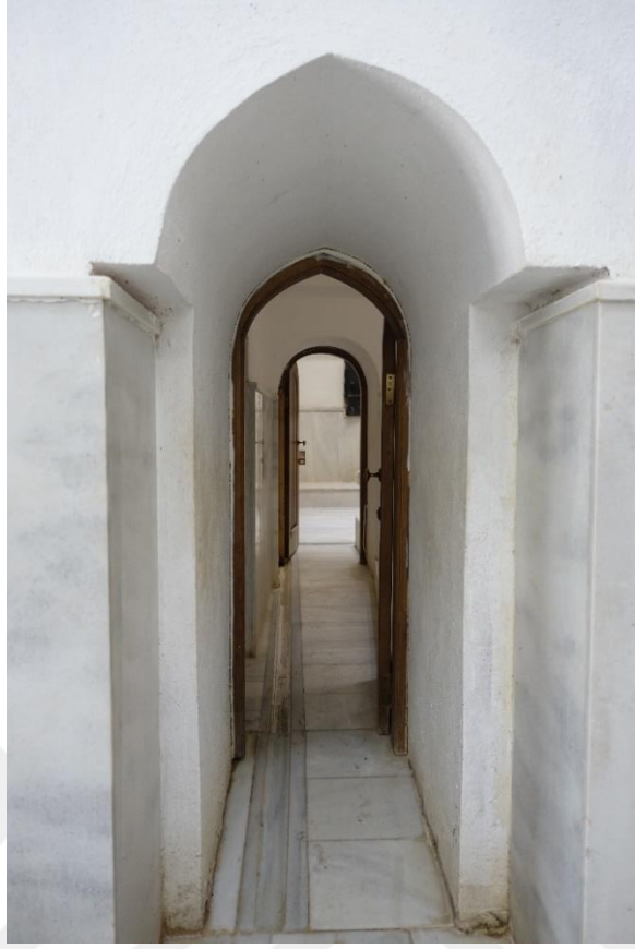
Fotoğraf 120: Baba Sultan Hamamı ılıklığa geçiş kapısı
