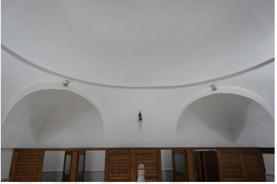
Fotoğraf 116: Baba Sultan Hamamı soğukluk kubbe geçiş trompu
