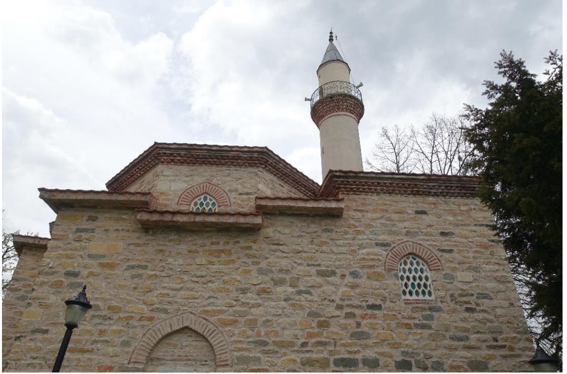
Fotoğraf 63: Baba Sultan Türbesi güney cephesi cephe saçakları
