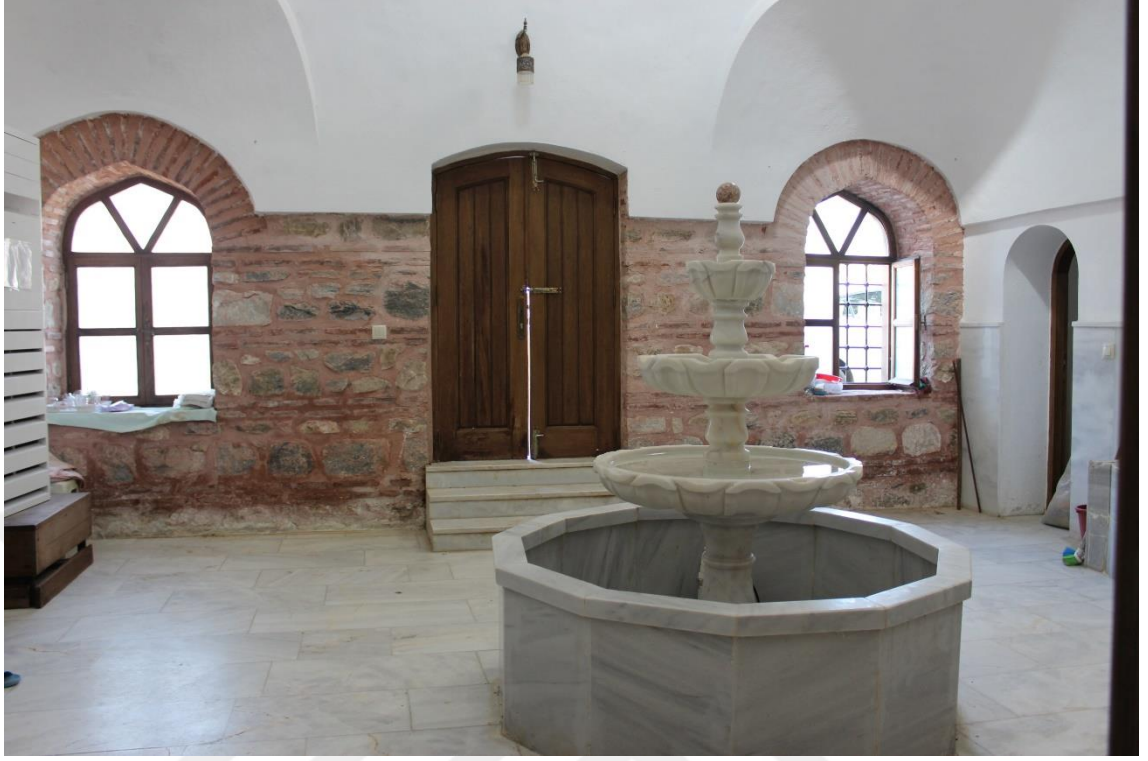
Fotoğraf 110: Baba Sultan Hamamı soğukluk kuzeydoğu iç cephesi
