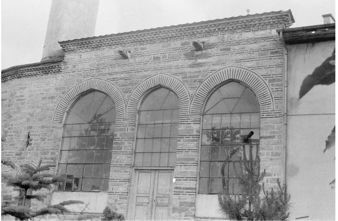
Fotoğraf 4: Baba Sultan Cami kuzey cephesi (1979)
