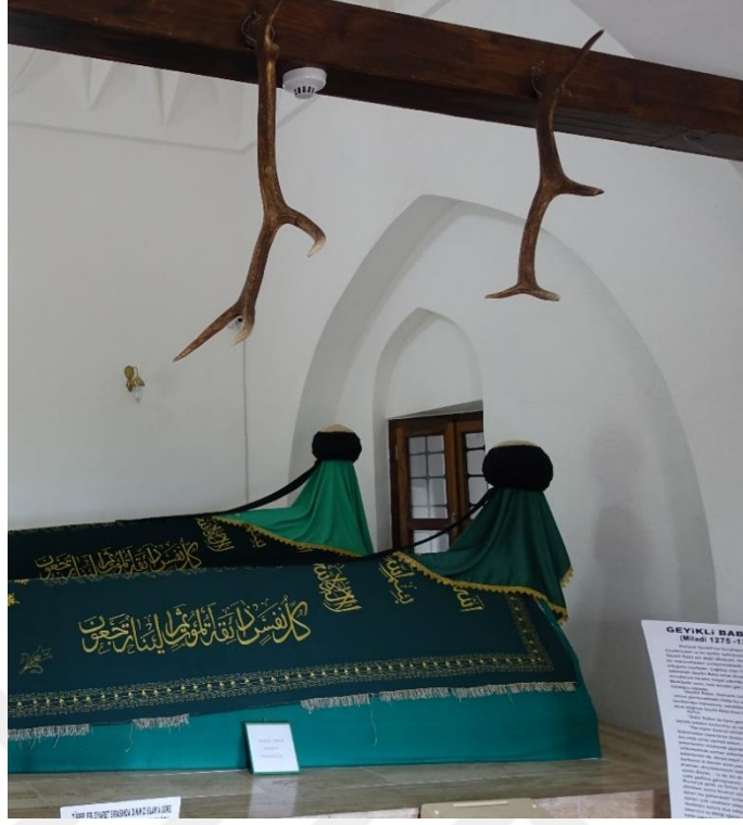
Fotoğraf 71: Baba Sultan Türbesi batı duvarı tahfif kemeri
