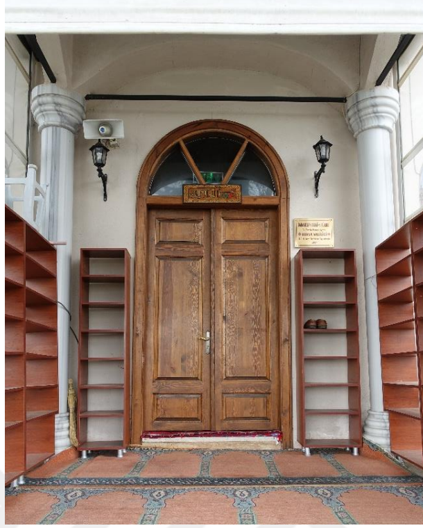
Fotoğraf 37: Baba Sultan Camii yeni cami giriş kapısı
