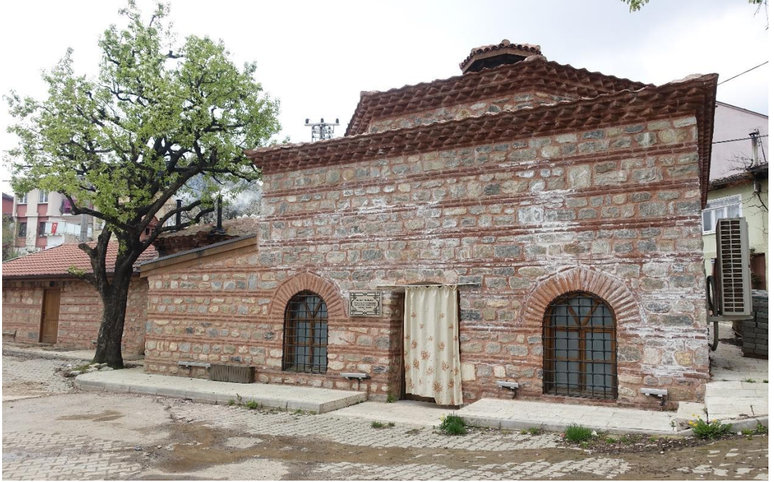
Fotoğraf 101: Baba Sultan Hamamı kuzeydoğu cephesi (soğukluk)
