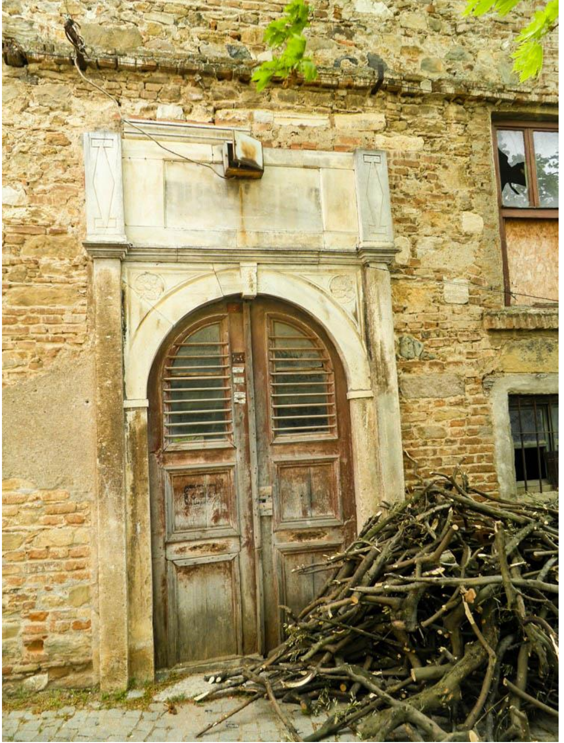
Şekil 62: Tirilye Ayios Ioannes Kilisesi Ana Giriş Kapısı (2019)
