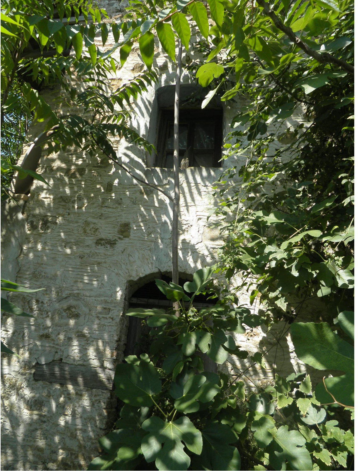
Şekil 70: Tirilye Mezarlık Kilisesi Doğu Cephe Görünümü (2019).
