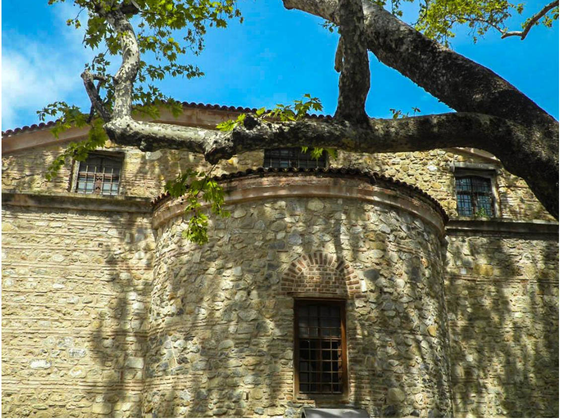
Şekil 56: Tirilye Ayios Yeoryios Kilisesi Doğu Cephe Görünümü (2019).
