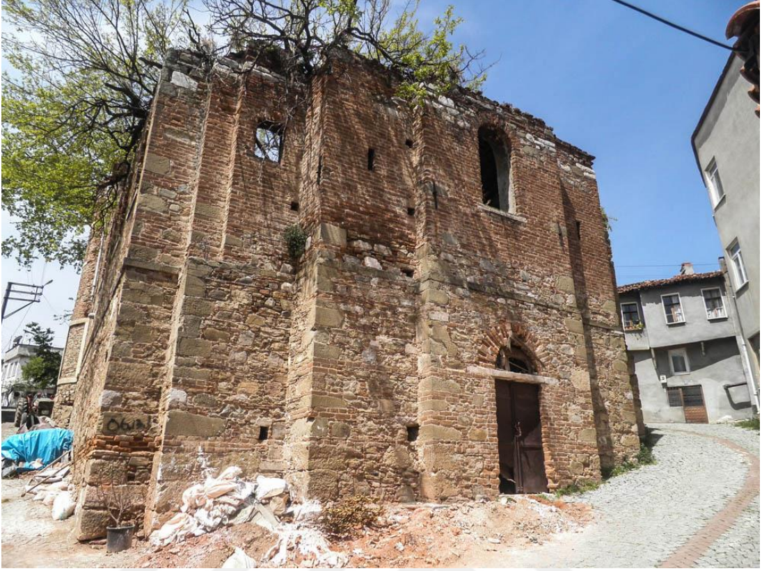
Şekil 65: Tirilye Ayios Ioannes Kilisesi Doğu Cephe Görünümü (2019).
