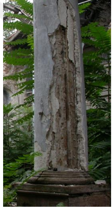
Şekil 43: Dereköy Ayia Paraskevi Kilisesi Ahşap Dikme Şekil 44: Dereköy Ayia Paraskevi Sıvalı Dikme
