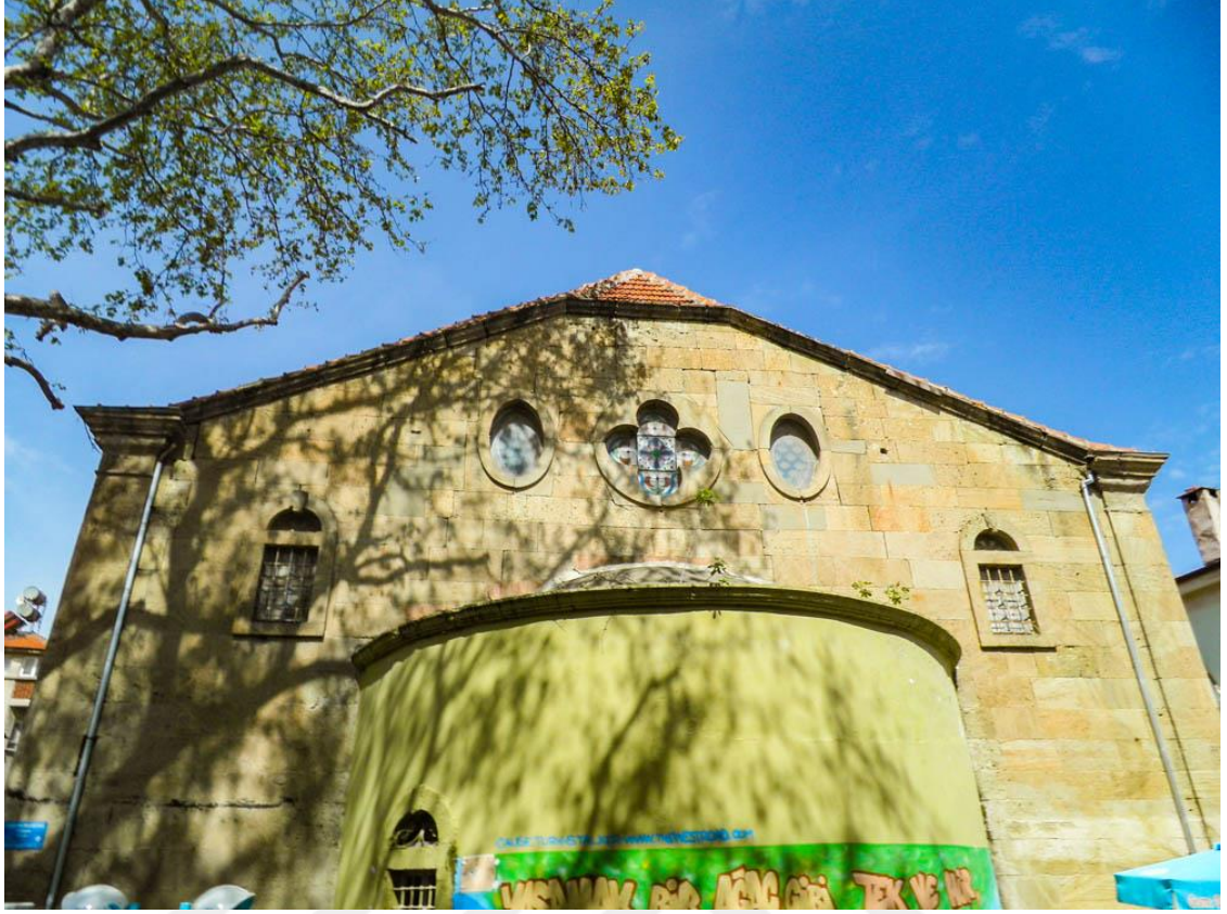
Şekil 7: Mudanya Ayios Yeoryios Kilisesi Doğu Cephe Görünümü (2019).
