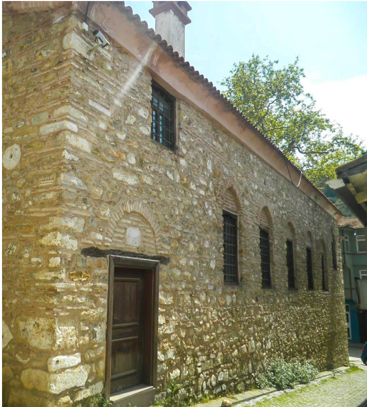
Şekil 55: Tirilye Ayios Yeoryios Kilisesi Güney Cephe Görünümü (2019).
