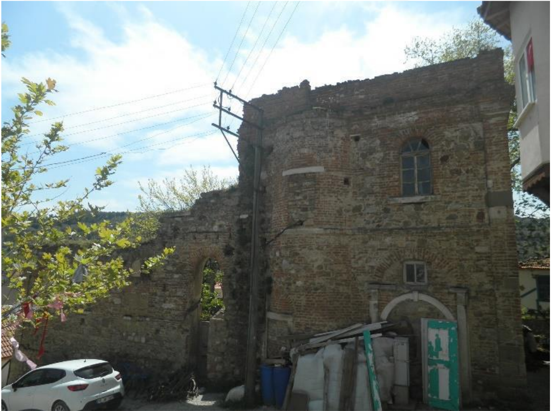
Şekil 64: Tirilye Ayios Ioannes Kilisesi Kuzey Cephe Görünümü (2019).
