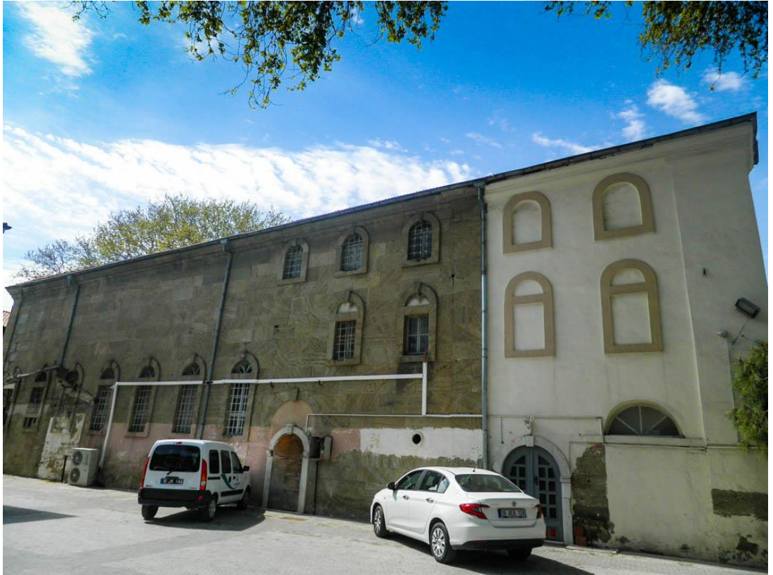
Şekil 6: Mudanya Ayios Yeoryios Kilisesi Kuzey Cephe Görünümü (2019).
