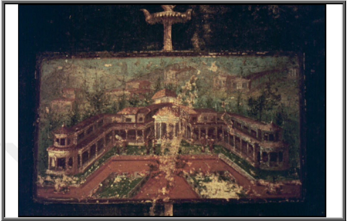
a- Villa Urbana Duvar Resimi
