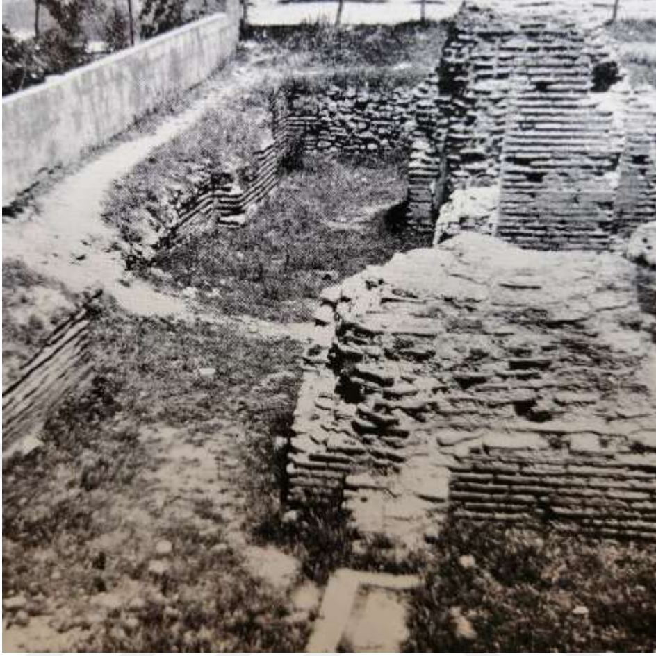
Resim 3: Kubbeyi taşıyan masif ayaklar (Peschlow 1972: Tafel 39. 1).
