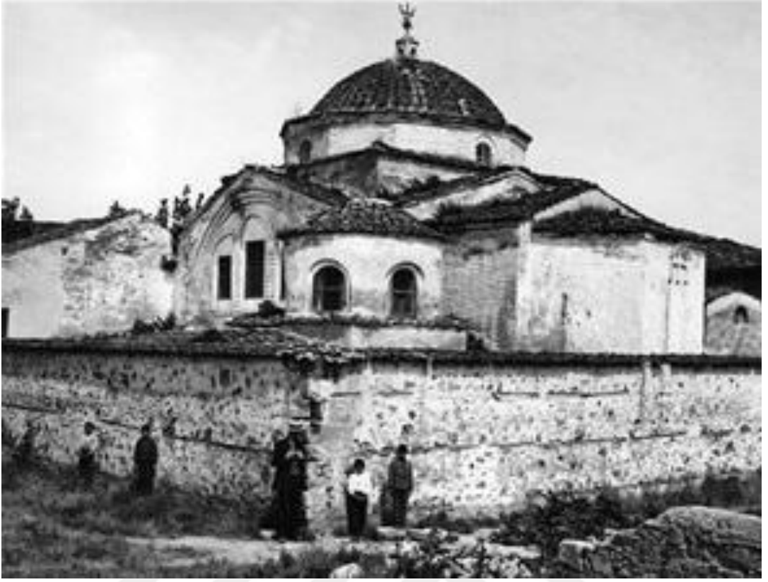
Resim 34: Koimesis Kilisesi yıkılmadan önceki görünümü ( Schmit, 1927).
