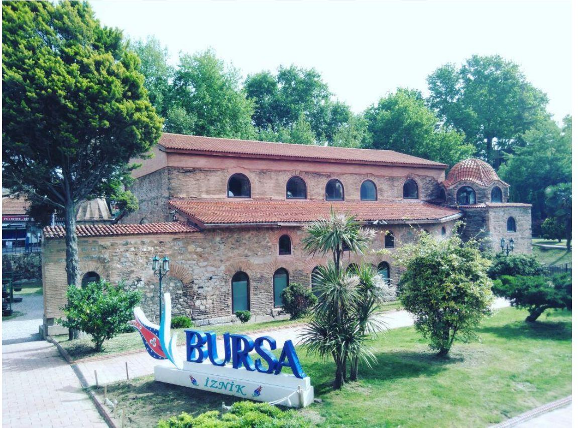
Resim 20. İznik Ayasofya Kilisesi güney cephesinin güneybatıdan görünümü.
