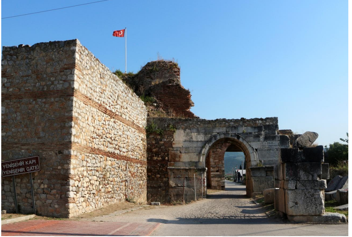
Resim 13. Yenişehir Kapı kent içinden görünümü 2019.
