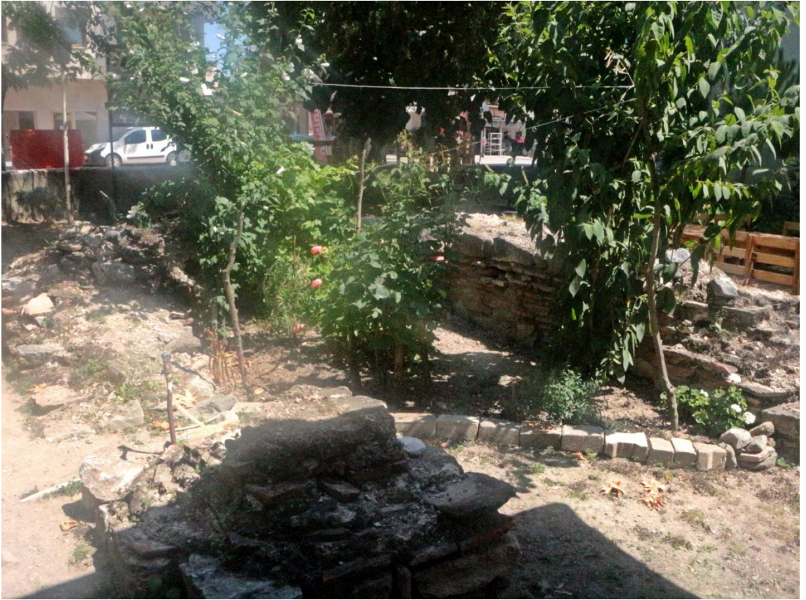
Resim 40: İstanbul Kapı yakınındaki kilisenin kuzeybatıdan görünümü.
